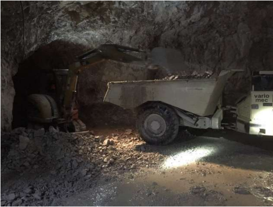
Mini Escavatore tipo "Caterpillar 305E2CR"
