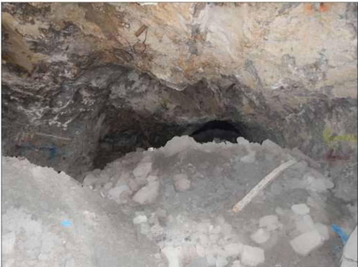
Punto 1 - Galleria ostruita da materiale.
