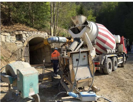
Betoniera e pompa per spritzbeton
