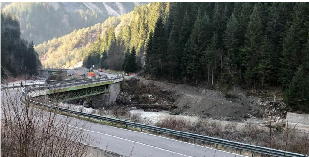
Figura 5: Esempio dei danni alluvionali lungo la S.S. N. 52 in corrispondenza del 2° ponte metallico sul Piave (Fonte: Lista di controllo)
