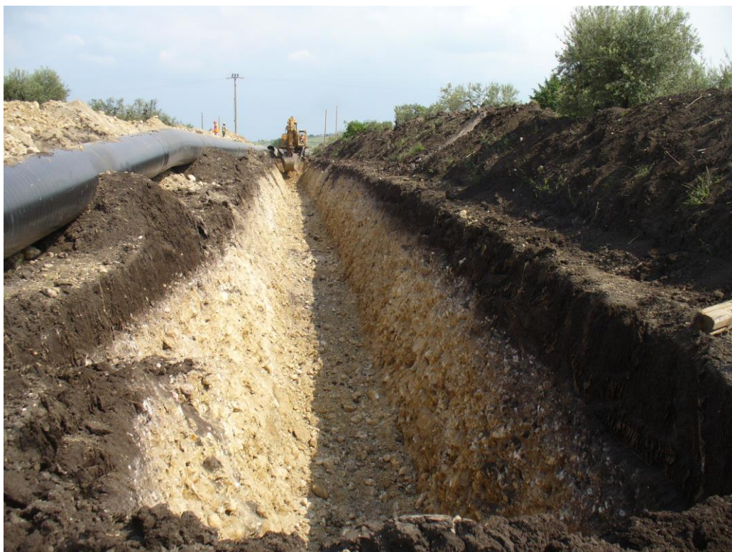
Fig. 3.2/D: Scavo della trincea
