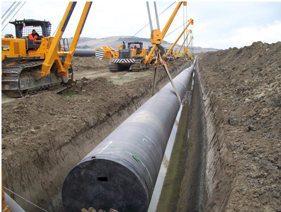
Fig. 3.2/E: Posa della condotta
