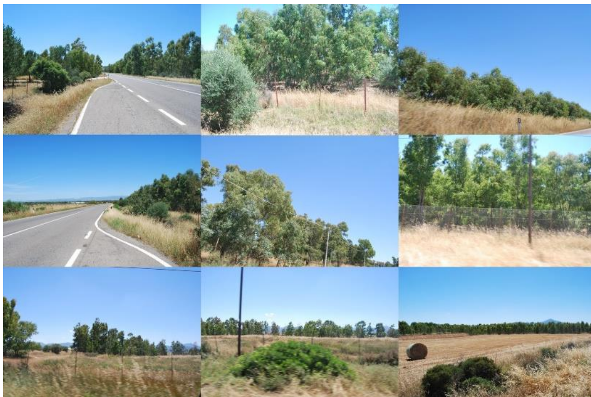
Fig. 6.1/O: Tracciato situato nell'agro e nell'area industriale – artigianale di Macchiareddu
