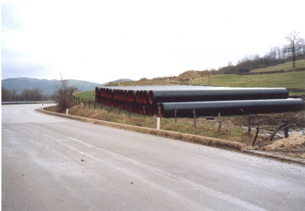
Fig. 3.2/A: Piazzola di accatastamento tubazioni
