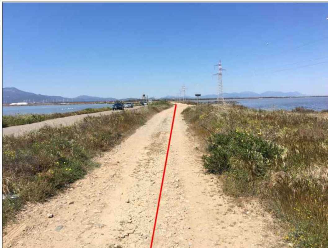
Percorrenza della condotta su strada bianca comunale, in prossimita' dello Stagno di Cagliari
