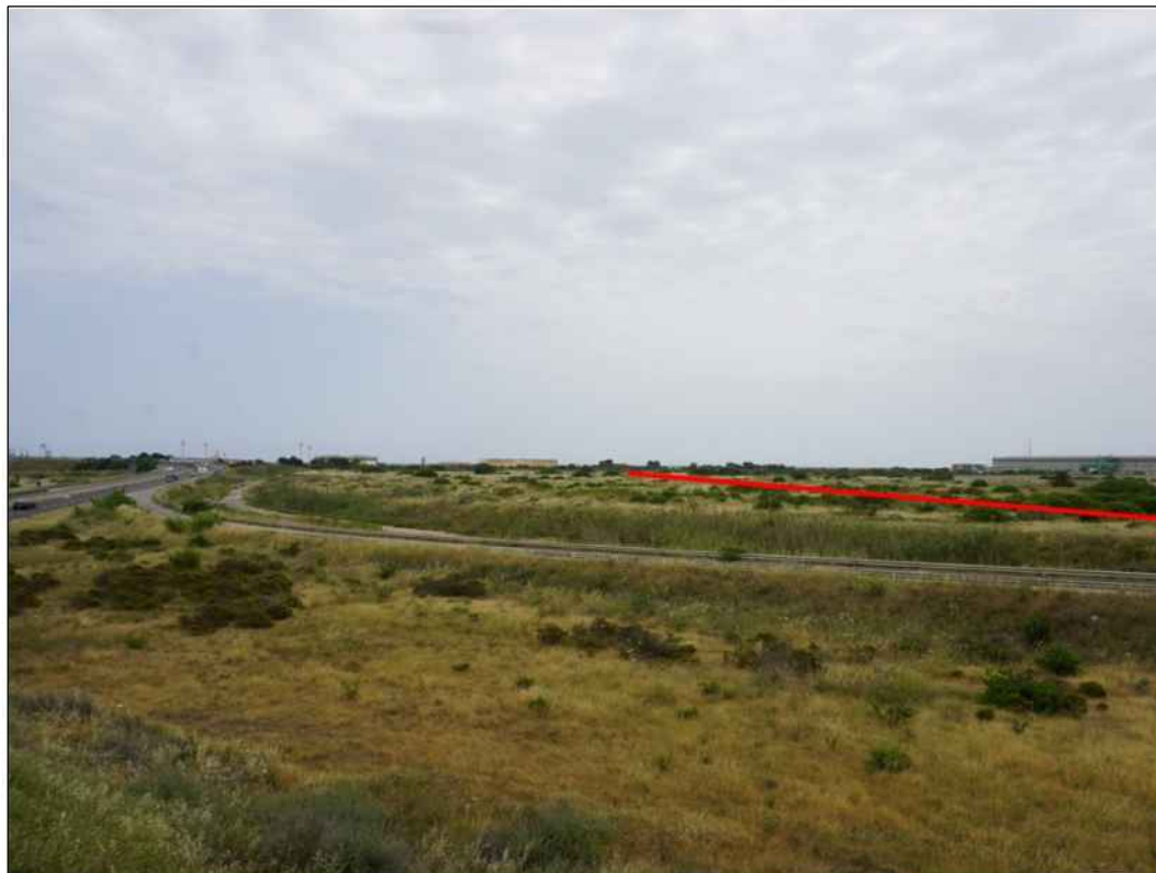
Panoramica della condotta in prossimità della S.S. n. 195 Sulcitana in Comune di Cagliari
