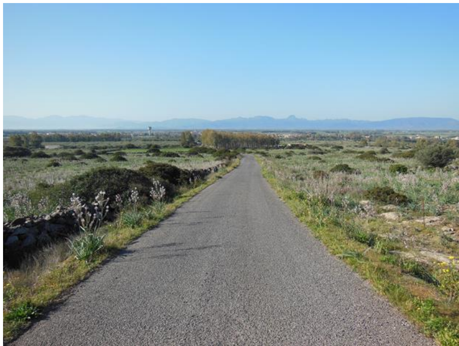
Foto 3/E: Met. Cagliari - Palmas Arborea: Attraversamento Strada Comunale tra superfici incolte in Comune di Uras
