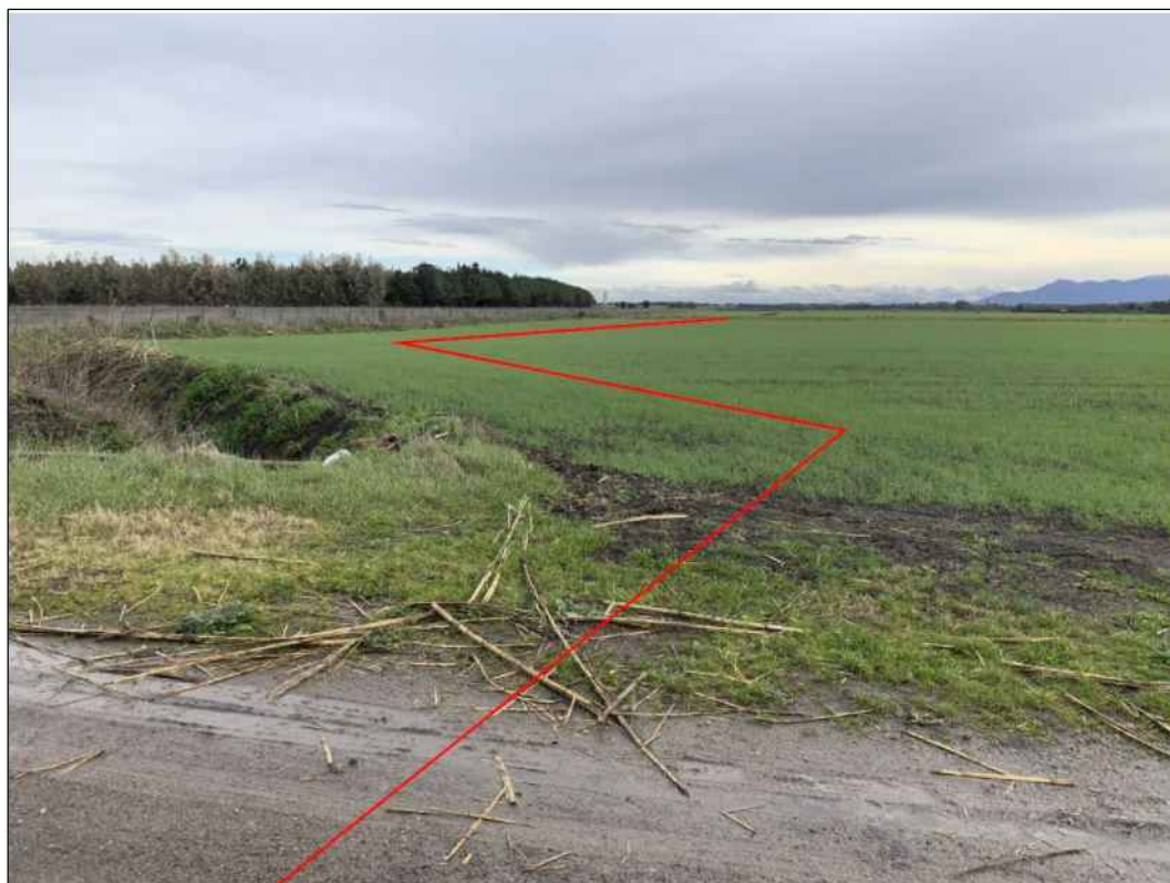
Percorrenza della condotta in seminativi, in Comune di Uras
