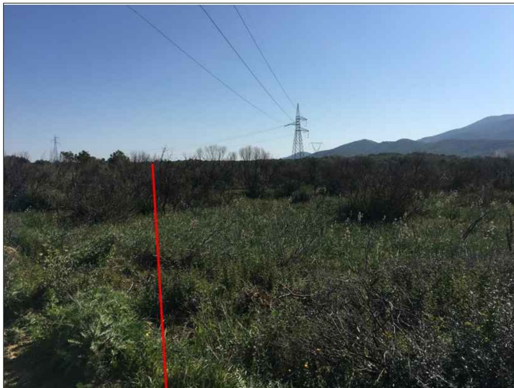
Percorrenza della condotta a nord-ovest della frazione di Corongiu, in Comune di Carbonia
