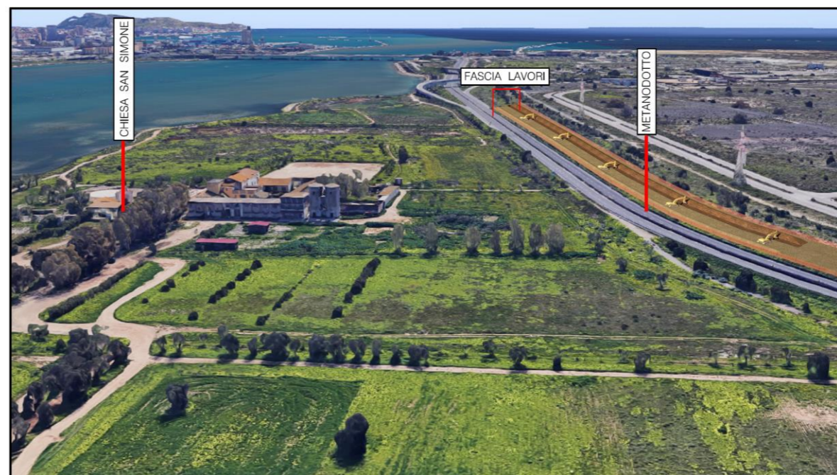
FASE DI CANTIERE
