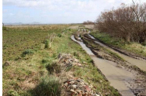
Visione generale della strada di accesso verso sud est (foto 1).
