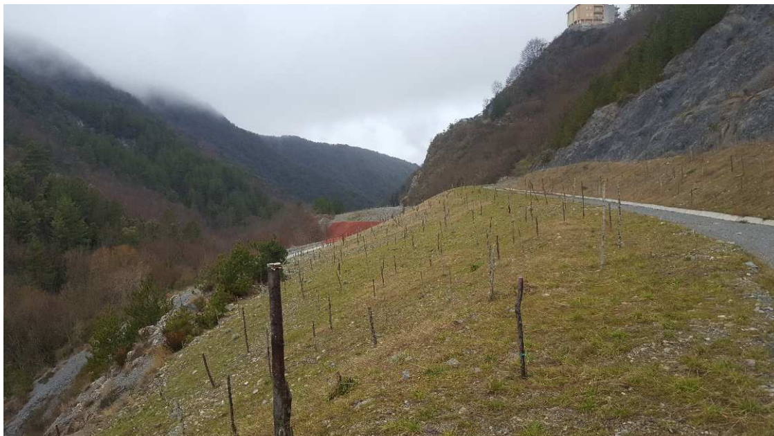
Figura 4 Piantumazione area Viadotto La Pineta demolito
