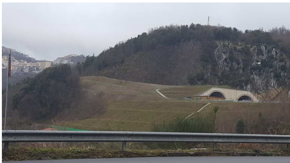
Zona Svincolo di Mormanno– stato di fatto al termine del rimodellamento morfologico e piantumazione
