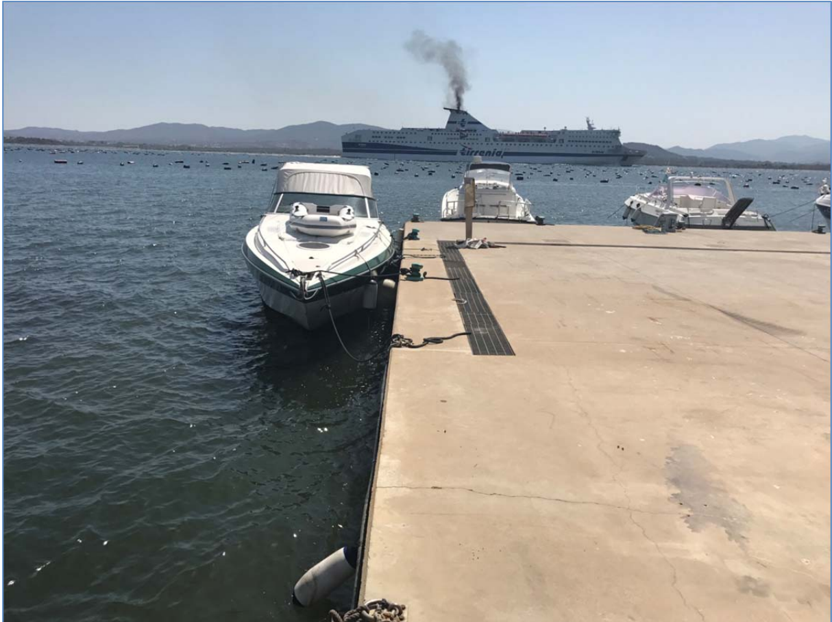
Figura 1 Canaletta esistente per la raccolta acque di prima pioggia
