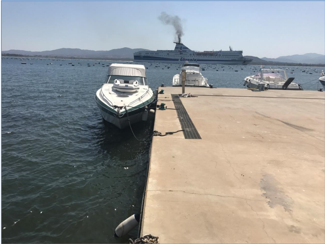
Figura 4 Canaletta esistente per la raccolta acque di prima pioggia
