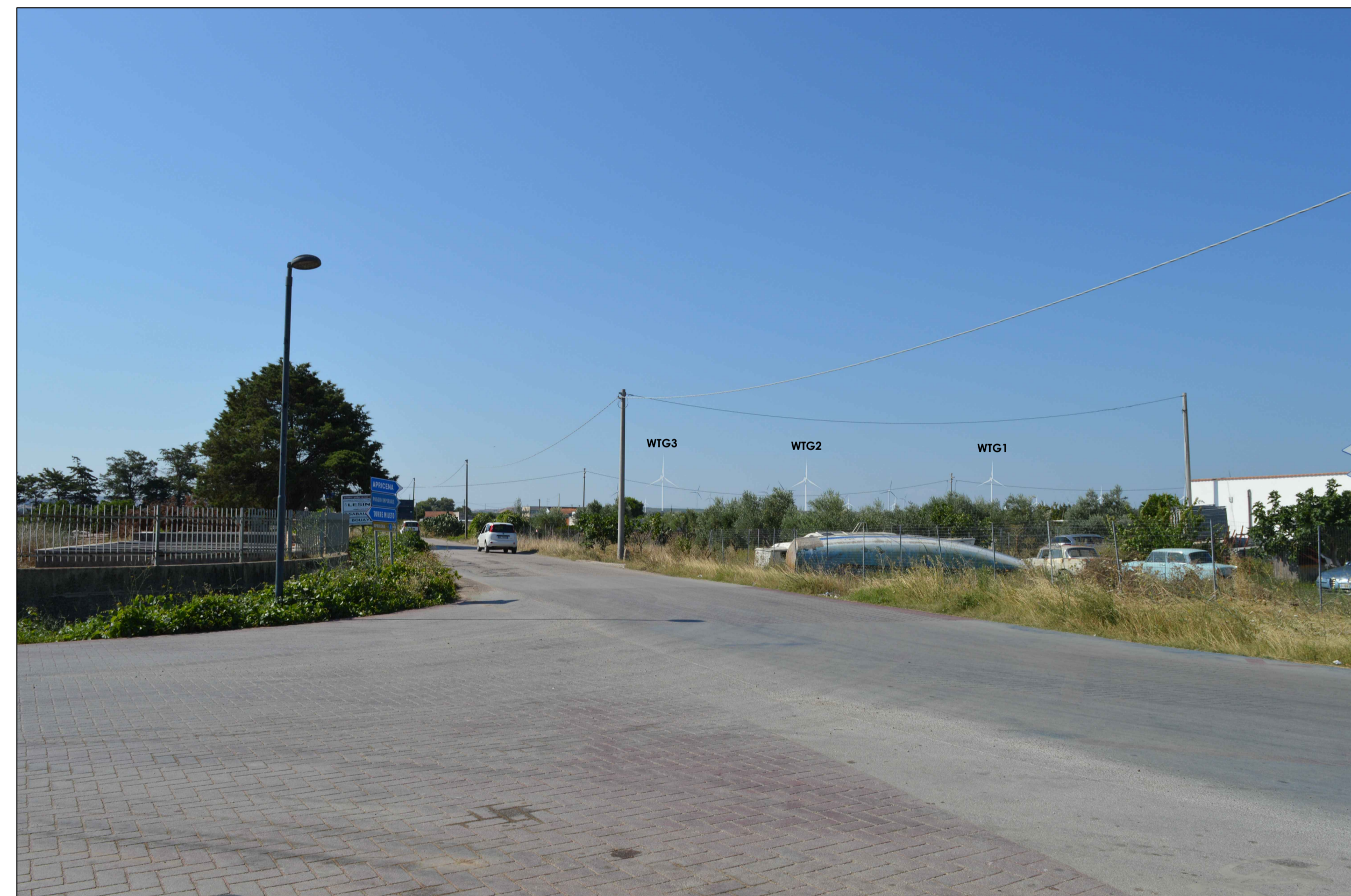
ESISTENTI - AUTORIZZATI - PROGETTO IVPC Power 6 Srl
