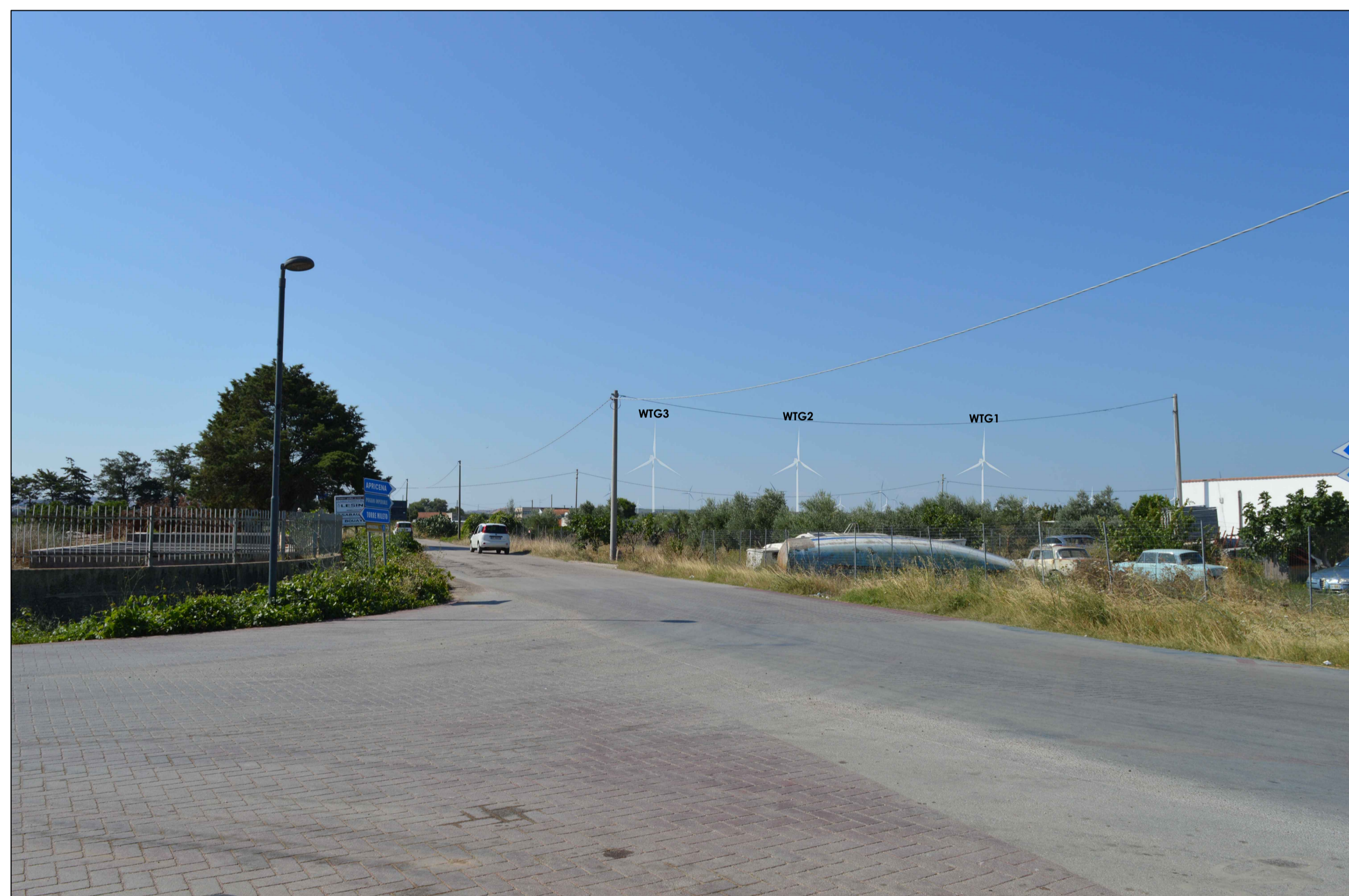
ESISTENTI - AUTORIZZATI - PROGETTO IVPC Power 6 Srl
