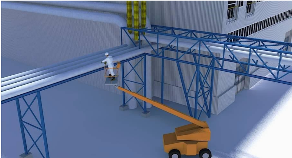
Accesso in quota tramite piattaforma aerea
