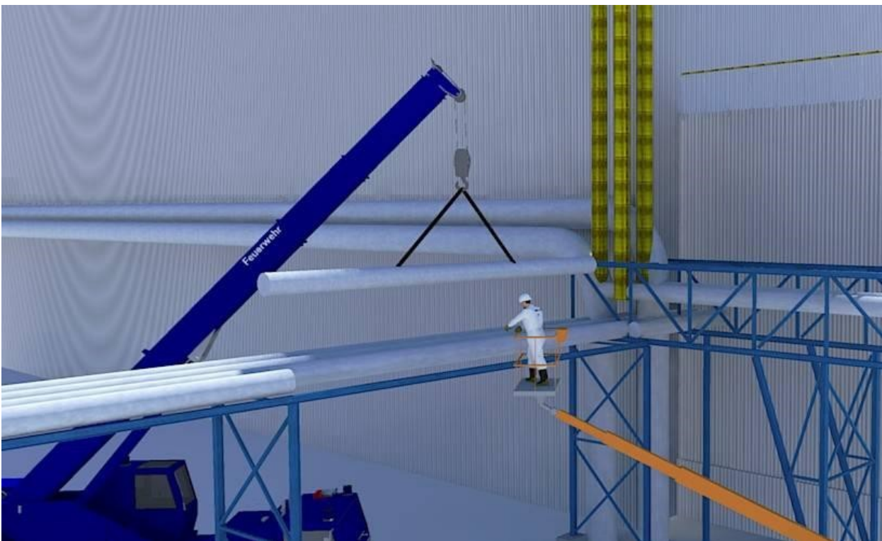
Sezionamento tubazione, sollevamento e calo a terra
