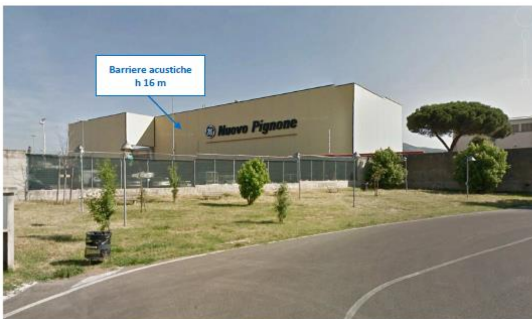
Vista esterna nella situazione attuale: distanza da barriere acustiche di circa 70, altezza fotocamera circa 2m.
