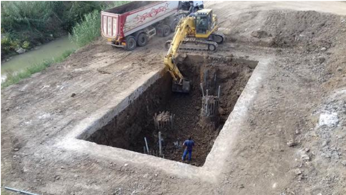
VIP03 – Pila n. 1 Scavo plinto di fondazione
