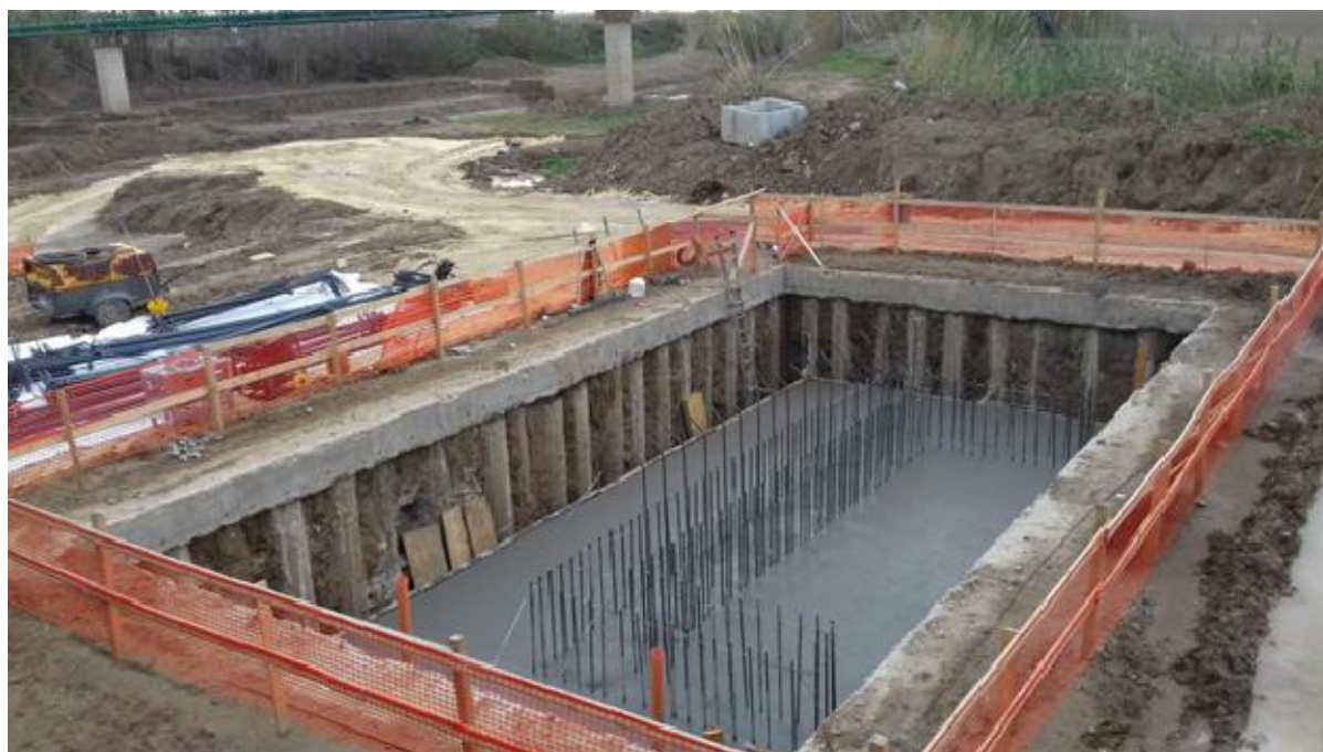
VIP03 – Getto cls plinto di fondazione Spalla A
