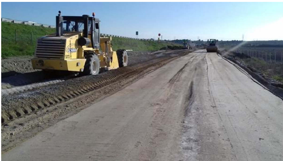
INP 200B Formazione rilevato Trattamento a calce sez. 6 sez. 16 circa
