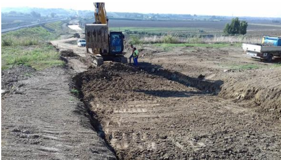
INP 200A Scavo per bonifica tra la sez. 17 e la sez. 37
