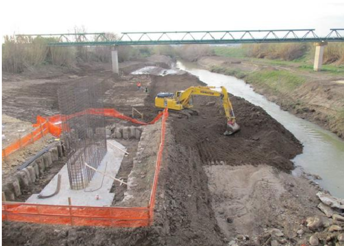
VIP03 – Plinto di fondazione Pila n.2 gettato
