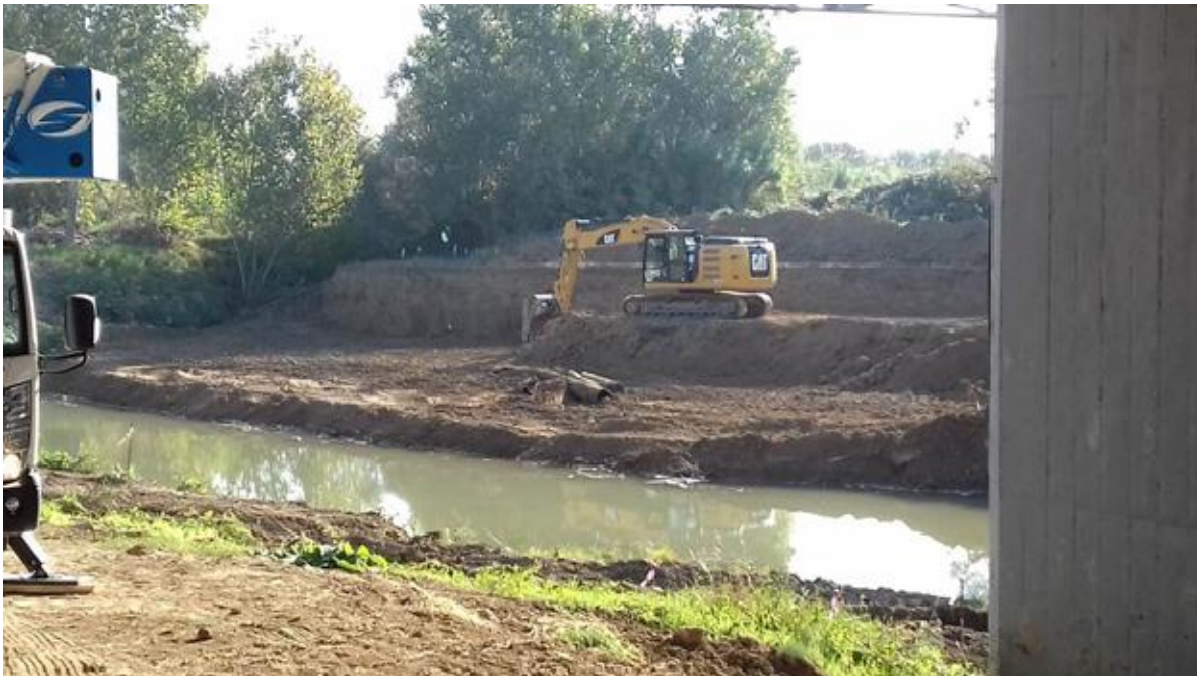
Riprofilatura alveo fiume Mignone – Scavo lato monte, in sponda idraulica sx
