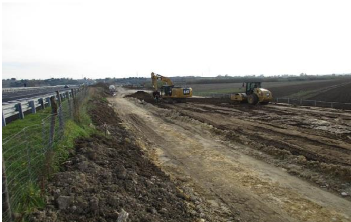
INP 200B Formazione rilevato Trattamento a calce sez. 16 sez. 26 circa
