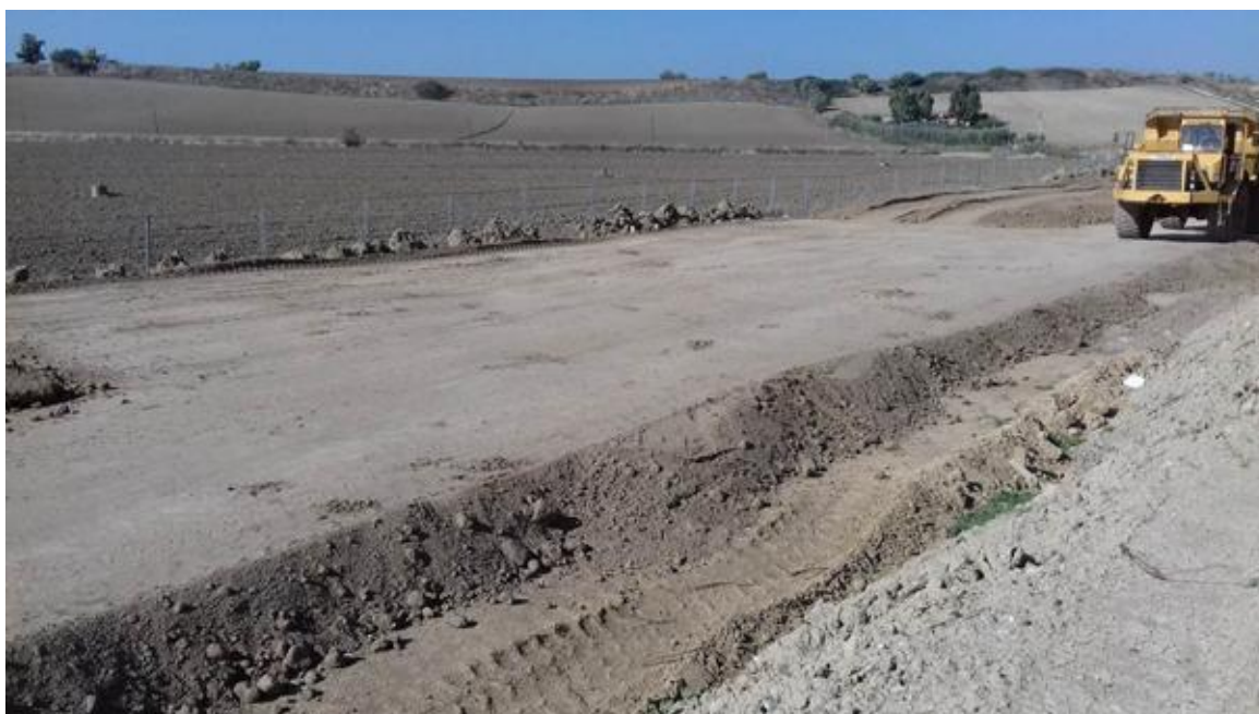
INP 200B – Formazione rilevato tra la sez. 6 e la sez. 26
