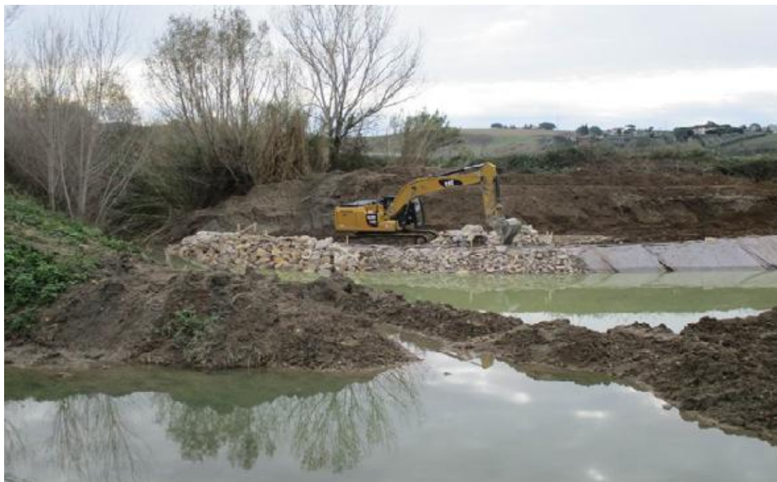
Riprofilatura alveo fiume Mignone – Inizio intervento in sponda sx lato monte
