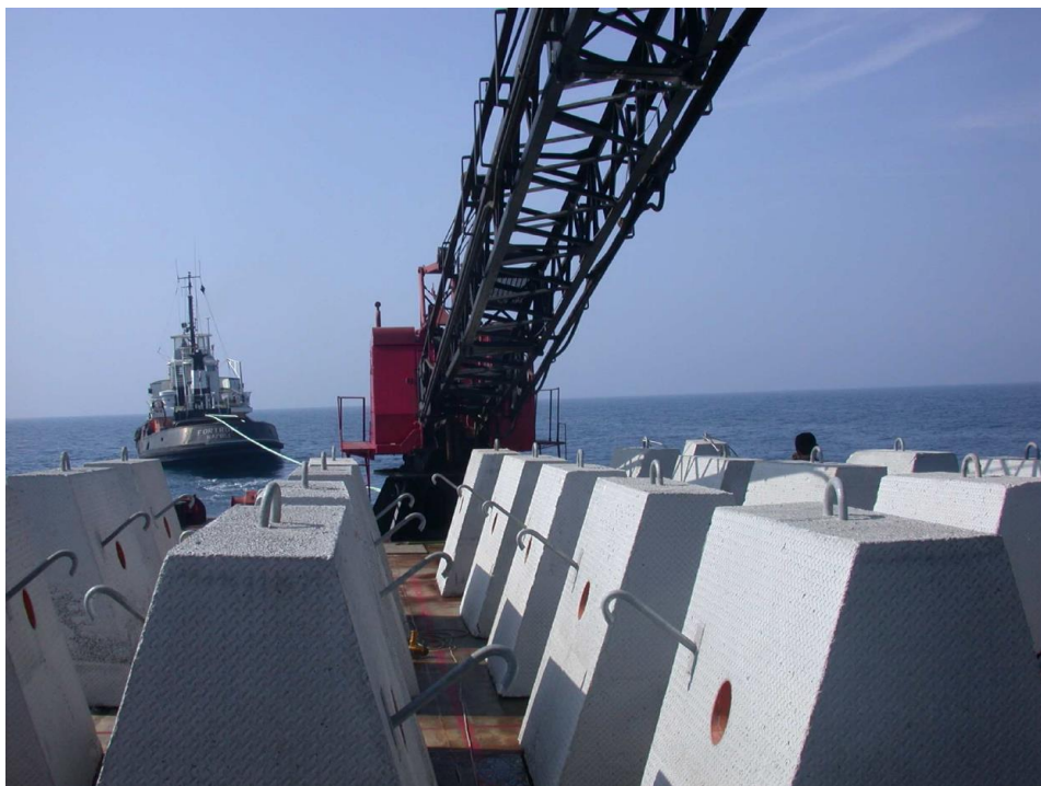
Figura 32 Le strutture di dissuasione a bordo del pontone prima della messa in mare
