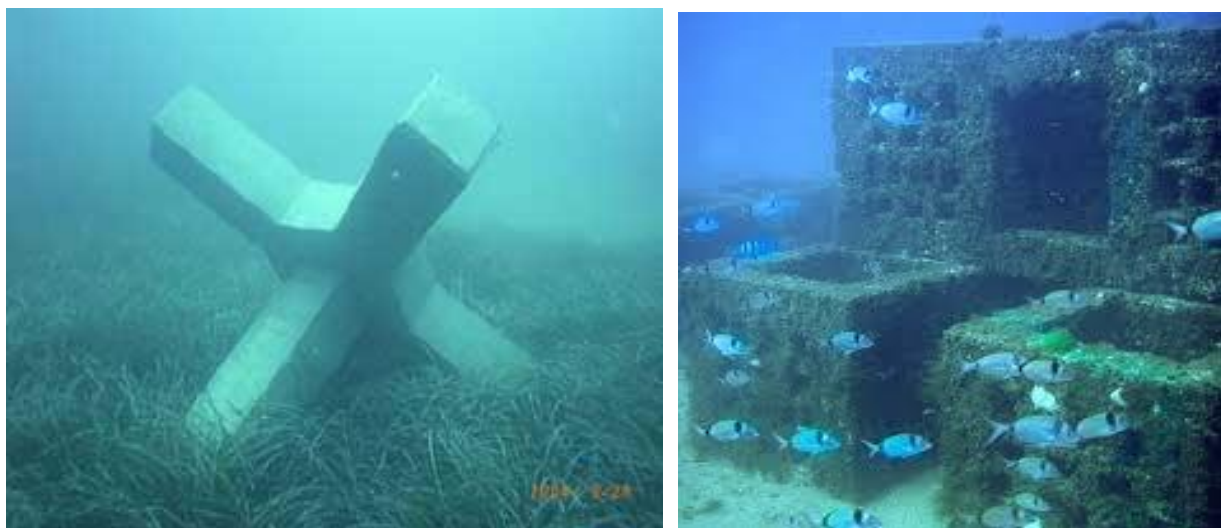
Figura 7 Strutture antistrascico per la protezione della Posidonia (a sinistra) e per il ripopolamento ittico (a destra) utilizzate in Spagna
