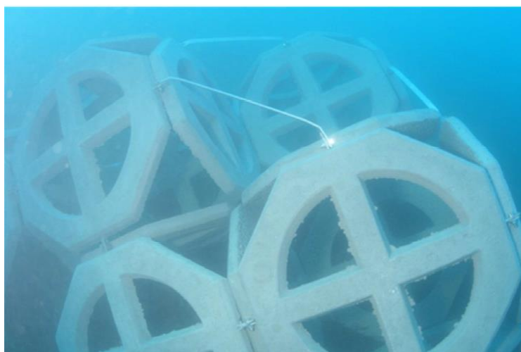
Figura 34 Il modulo TECNOREEF utilizzato a Frigole, in Puglia
