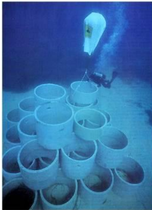
Figura 21 Strutture utilizzate per la barriera artificiale di Terrasini
