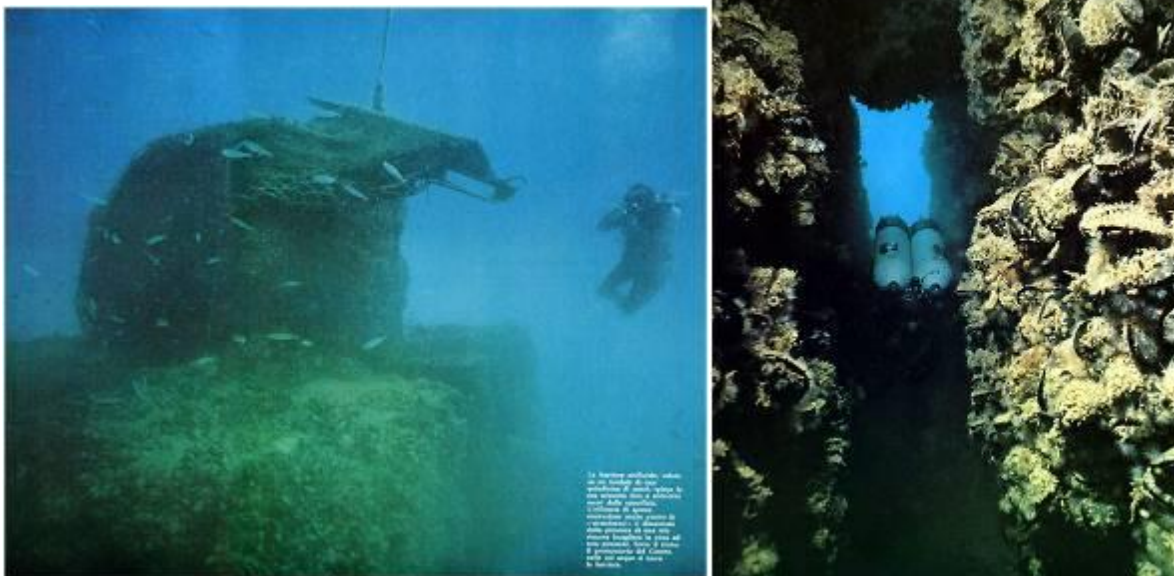
Figura 16 Effetto antistrascico delle barriere artificiali: rete rimasta impigliata su una piramide della barriera artificiale di Porto Recanati (a sinistra). Spazi tra i moduli di una barriera: è visibile la spessa copertura di mitili (a destra)
