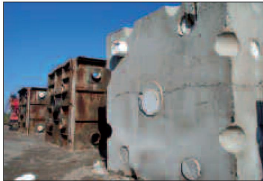
Figura 8 Casseformi in un cantiere a terra per la realizzazione di strutture artificiali
