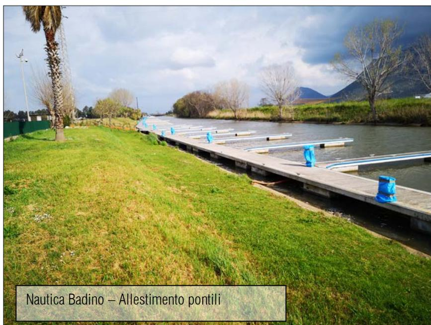
camminamenti in doghe di legno, sorretti da blocchi alleggeriti di galleggiamento, completi di pertinenze e sottoservizi (antincendio, linea elettrica e condotta idrica), accessibili mediante passerelle mobili, completi di bitte metalliche per
