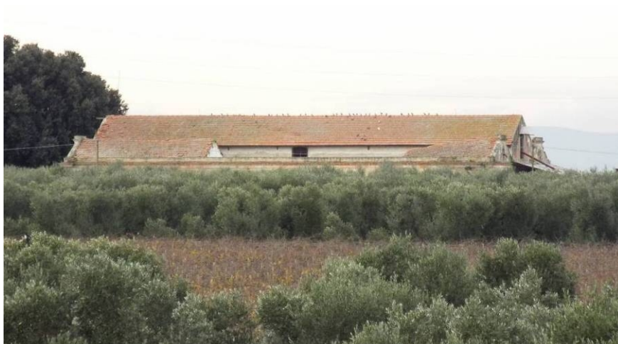
Foto P10: Vista della Masseria Contessa Mannelli, segnalata nel PPTR, oggi in stato di abbandono
