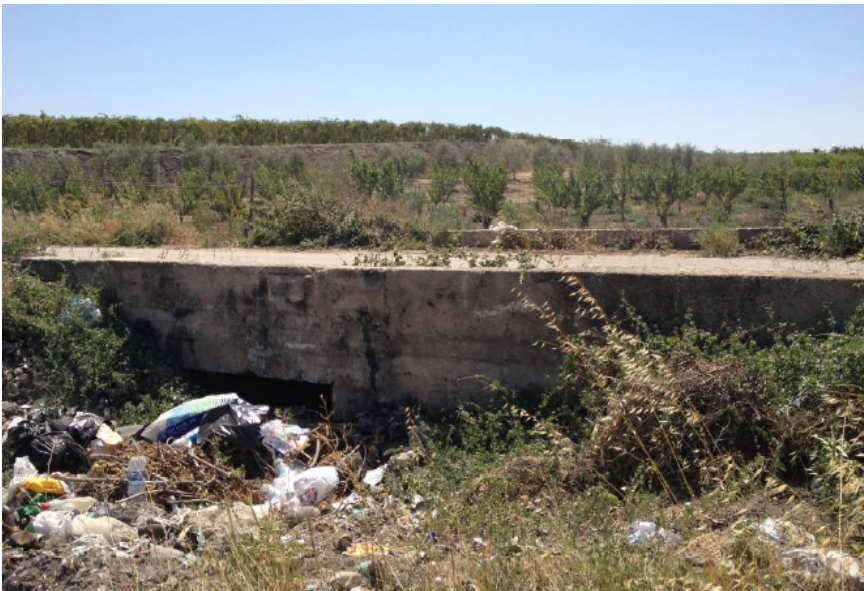
Foto P14.A: Vista della Marana Castello (segnalato nel PPTR), attraversato dal cavidotto esterno
