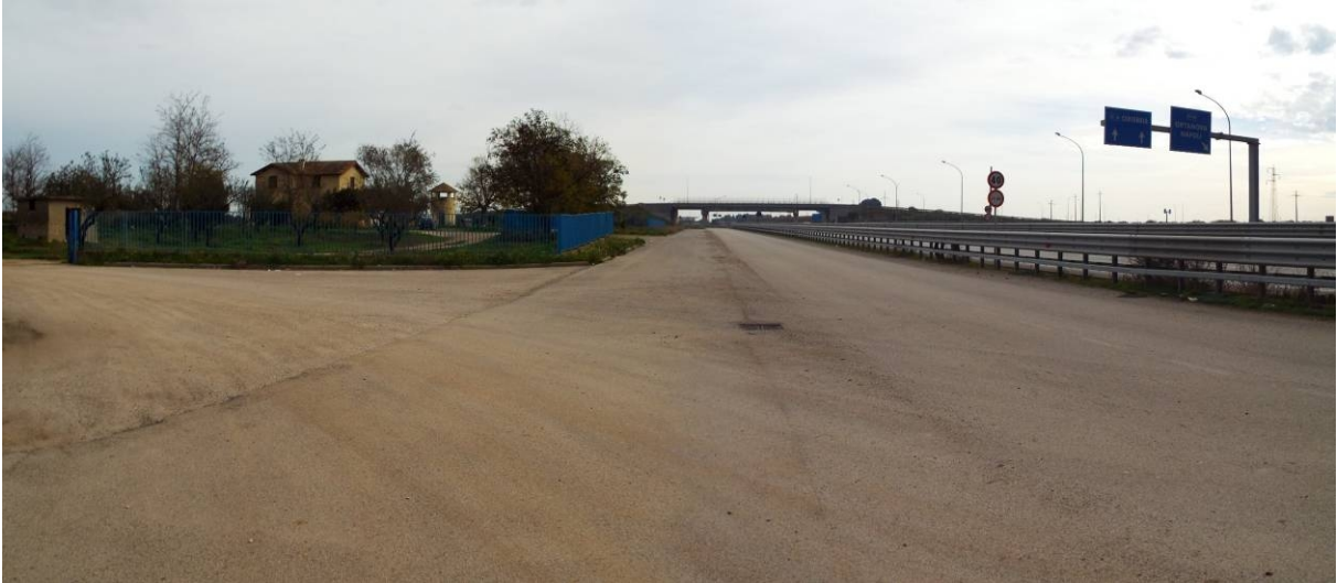
Foto P12.A: Vista della SS 16 e della Complanare alla Statale (Regio Tratturo Foggia – Ofanto nel PPTR), in prossimità della Marana La Pidocchiosa, a confine esterno dell'area di progetto
