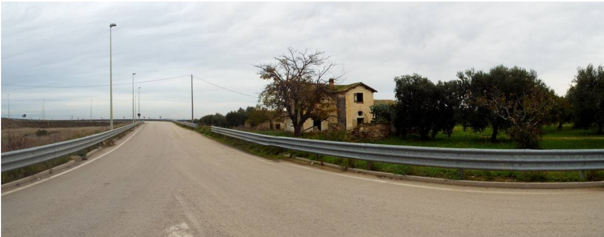
Foto P11.B: Vista della SP86, interessate dal passaggio del cavidotto, all'incrocio tra la complanare della SS 16 e la SP 86, entrambi tratti o traturelli segnalati nel PPTR, in prossimità dell'area di inserimento del WGT11
