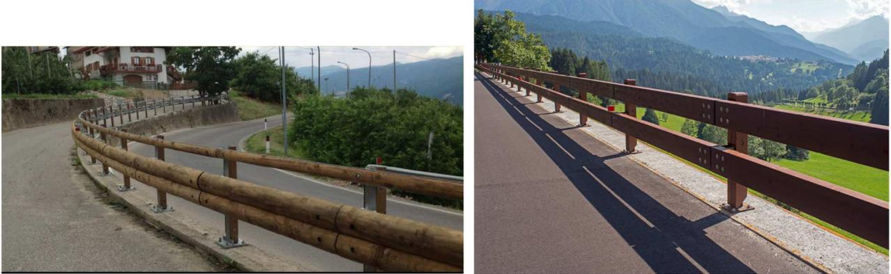
Figura 6 – Esempio di barriera commerciale in legno e acciaio, H2 bordo ponte
