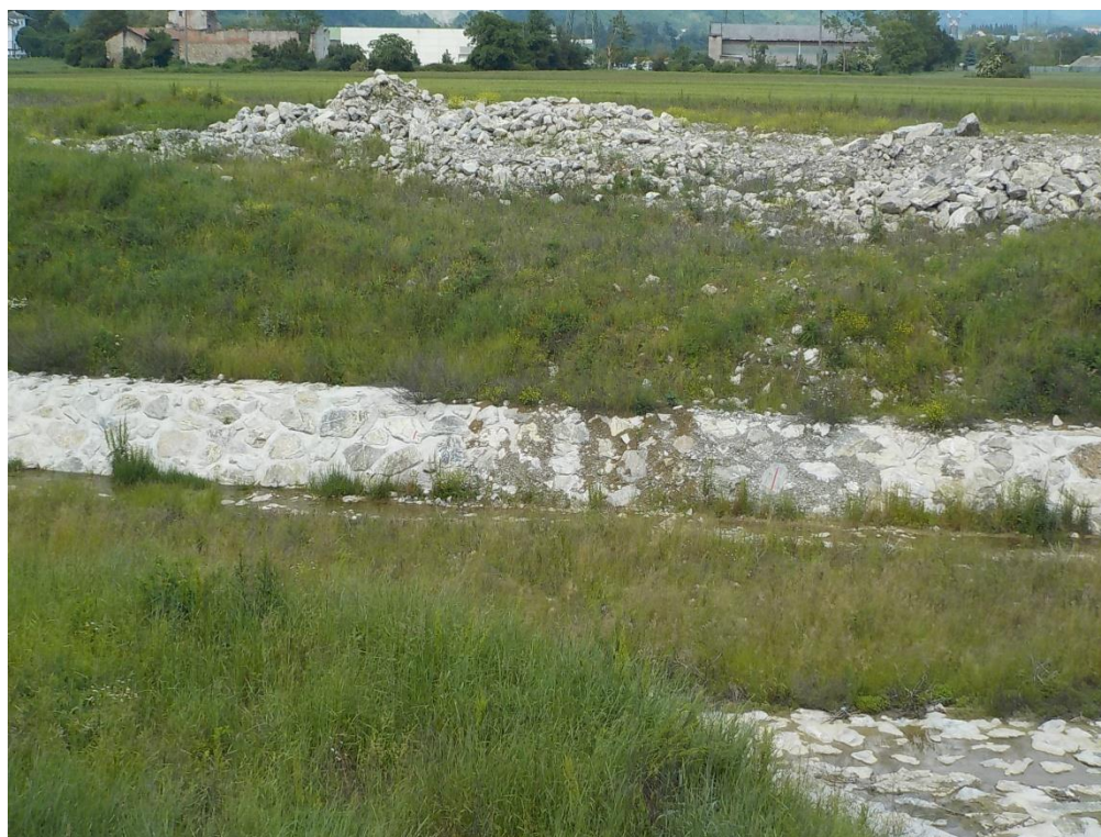
Figura 69: panoramica stazione di rilievo VEG-AR-500B
