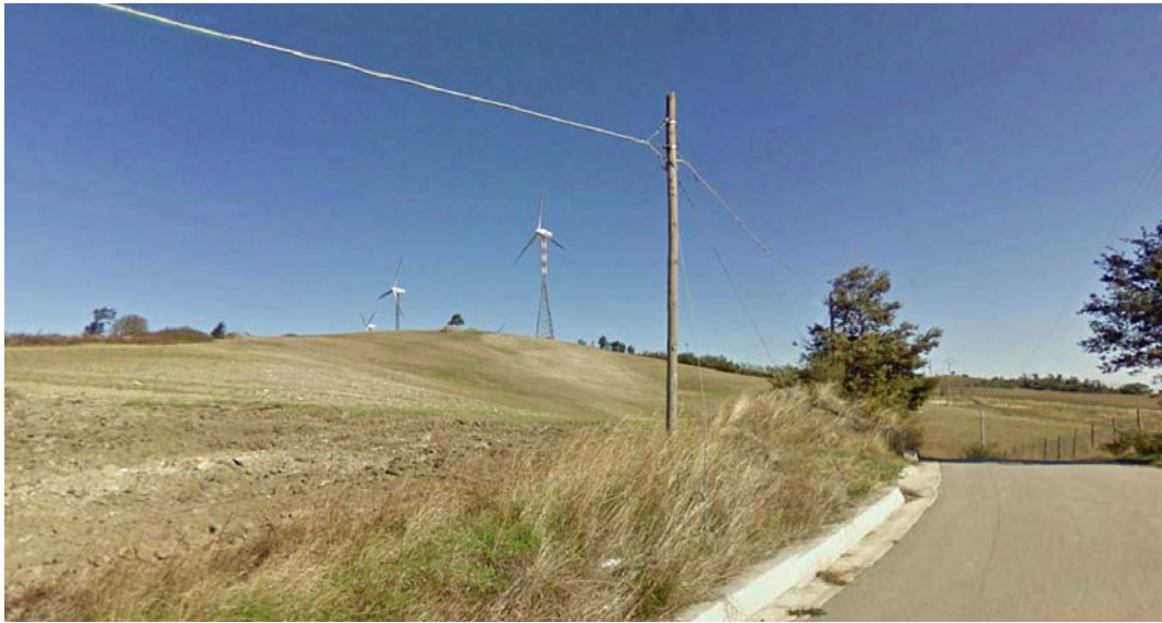
Figura 32: asse di fruizione visuale dinamica ad elevata velocità di percorrenza corrispondente alla strada comunale Piano della Staccia
