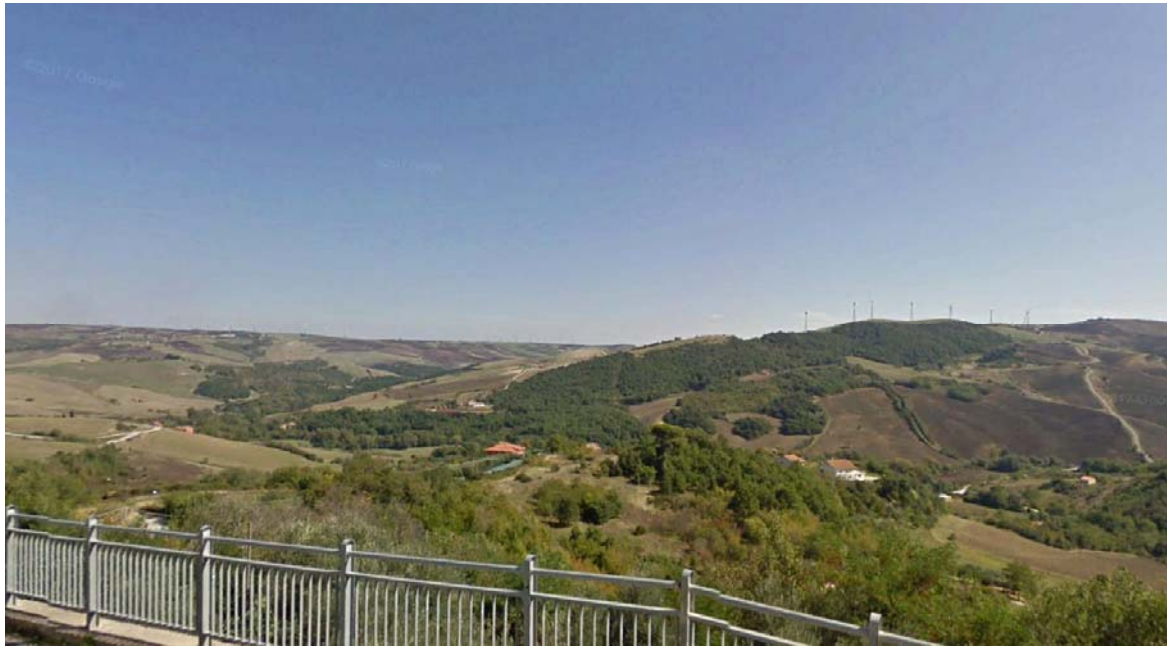
Figura 36: vista dal belvedere in posizione est dell'abitato di Lacedonia, sullo sfondo il tronco di aerogeneratori LC 23-LC38
