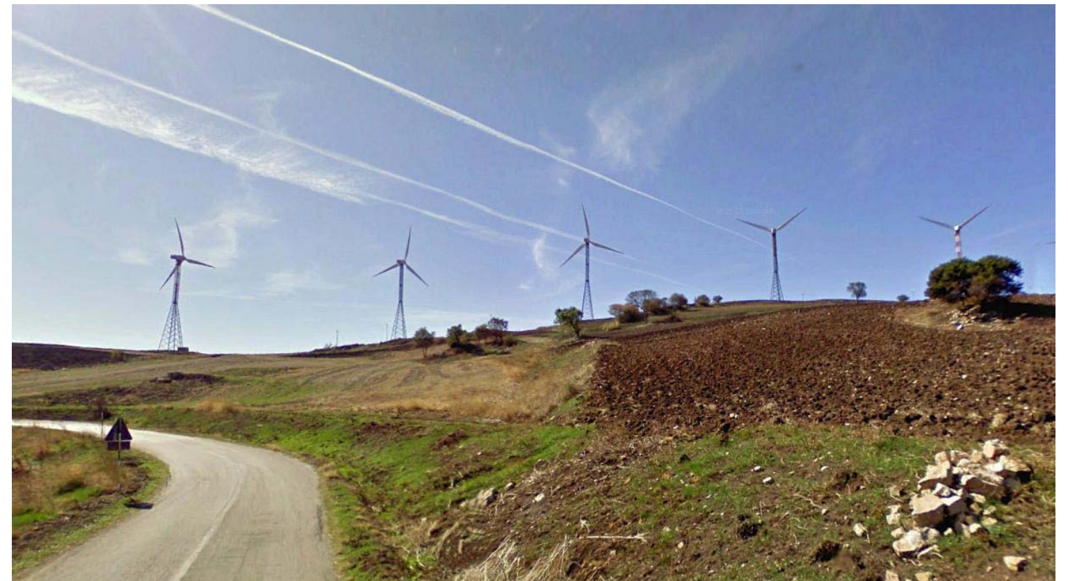
Foto 32: vista di dettaglio dalla SP51 degli aerogeneratori nel comune di Monteverde (tronco MV01-MV09), sono visibili li aerogeneratori MV05-MV09
