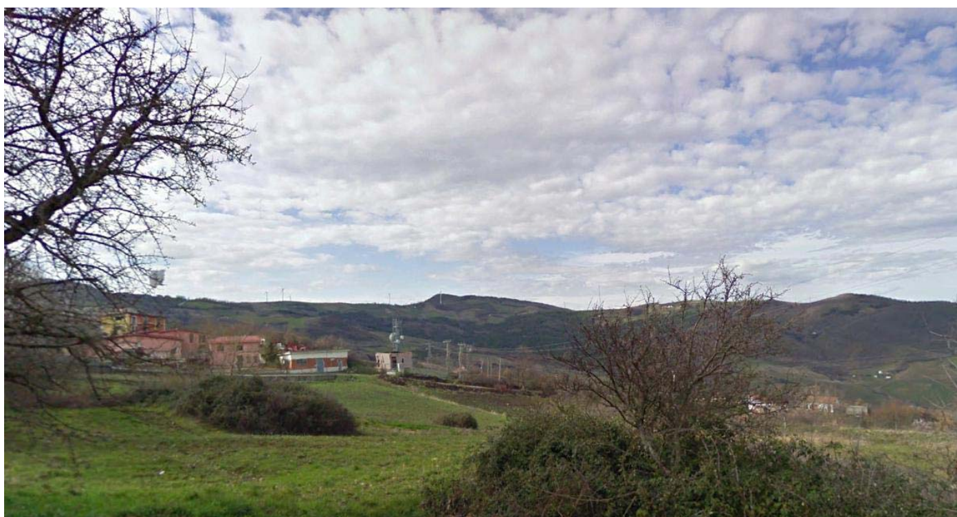
Foto 7: vista dall'abitato di Aquilonia verso gli ambiti interessati dagli interventi di reblading
