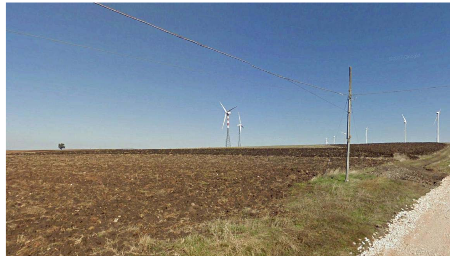
Foto 22: vista degli aerogeneratori LC39-LC40 oggetto di intervento, a destra aerogeneratori appartenenti ad un altro parco eolico.
