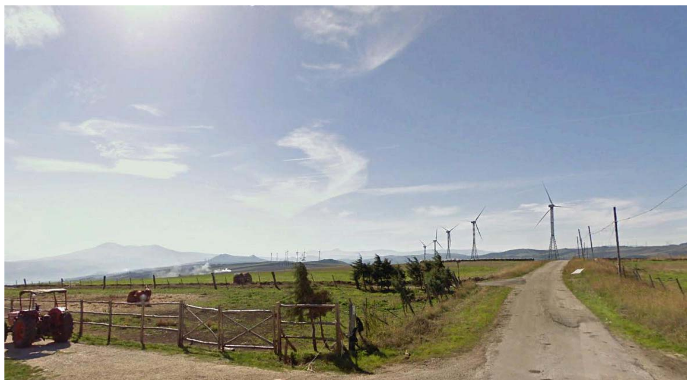
Foto 23: vista degli aerogeneratori LC41-LC45 oggetto di intervento
