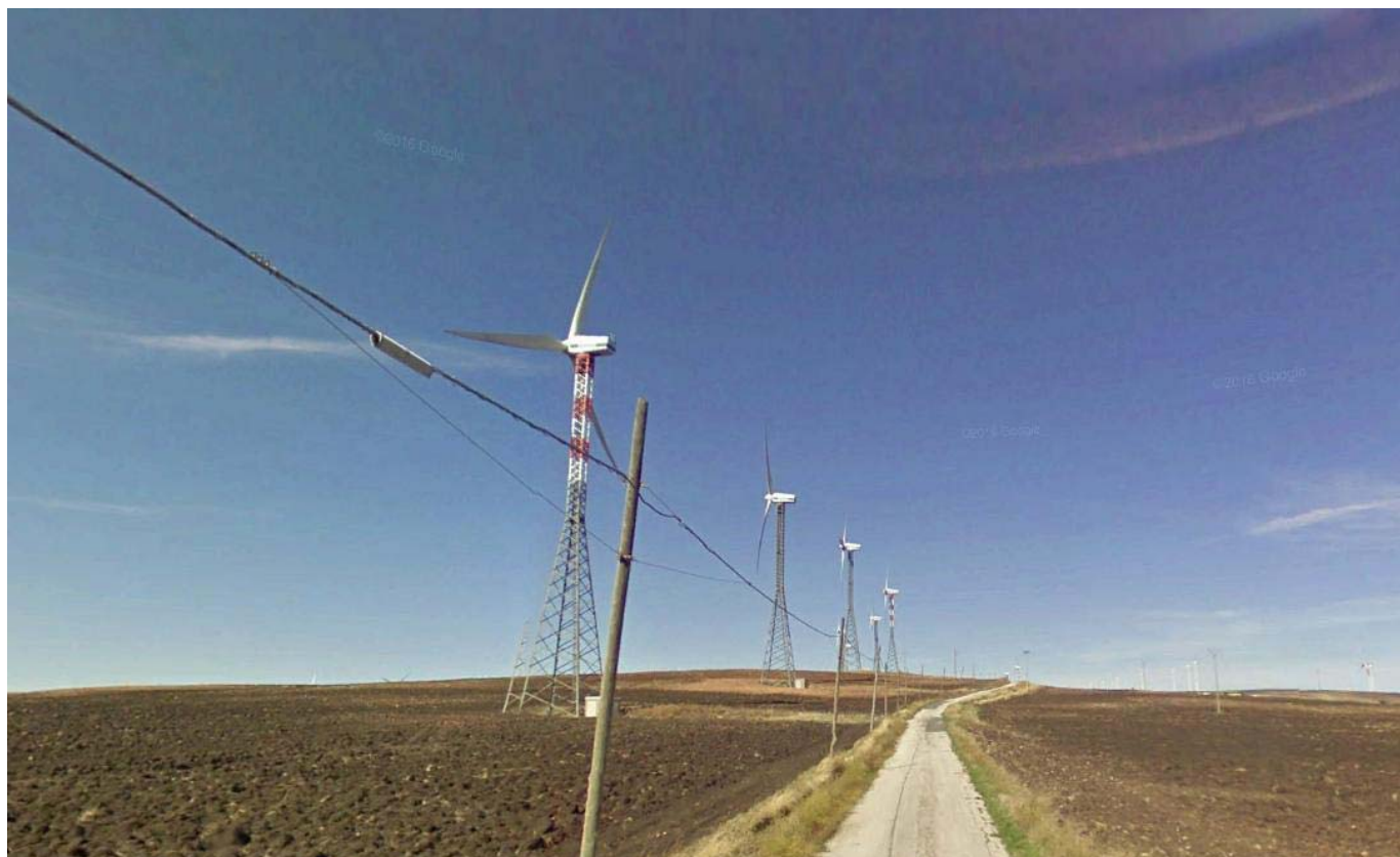
Foto 25: vista verso monte del tronco LC41-LC47, in primo piano l'aerogeneratore LC 47.
