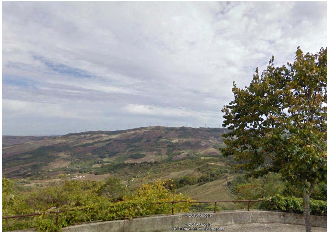
Foto 11: vista dal belvedere dell'abitato di Bisaccia verso gli ambiti di intervento, sullo sfondo sono visibili gli aerogeneratori oggetto di reblading (tronco LC01-LC22)
