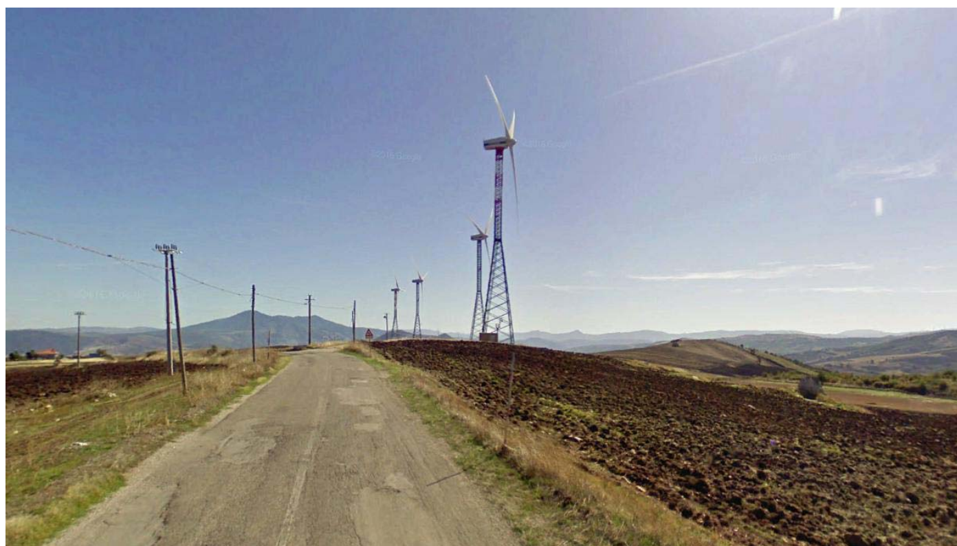
Foto 27: vista dalla SP6 verso valle del tronco LC48-LC54, sono visibili gli aerogeneratori LC51-LC54
