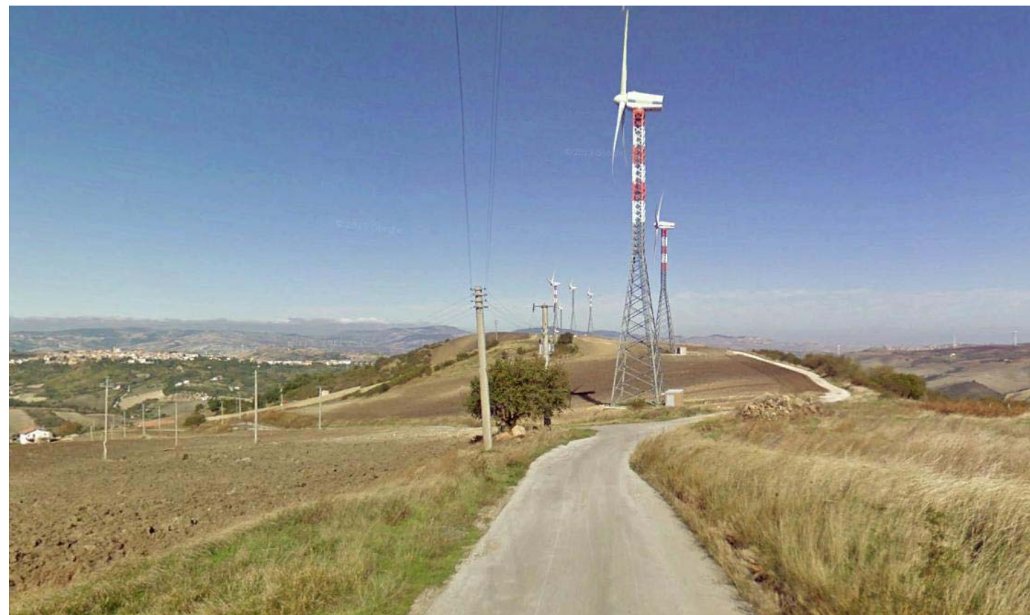
Foto 14: vista dei sostegni LC25-LC29 su ambiti a seminativo arato, sullo sfondo a sinistra l'abitato di Lacedonia
