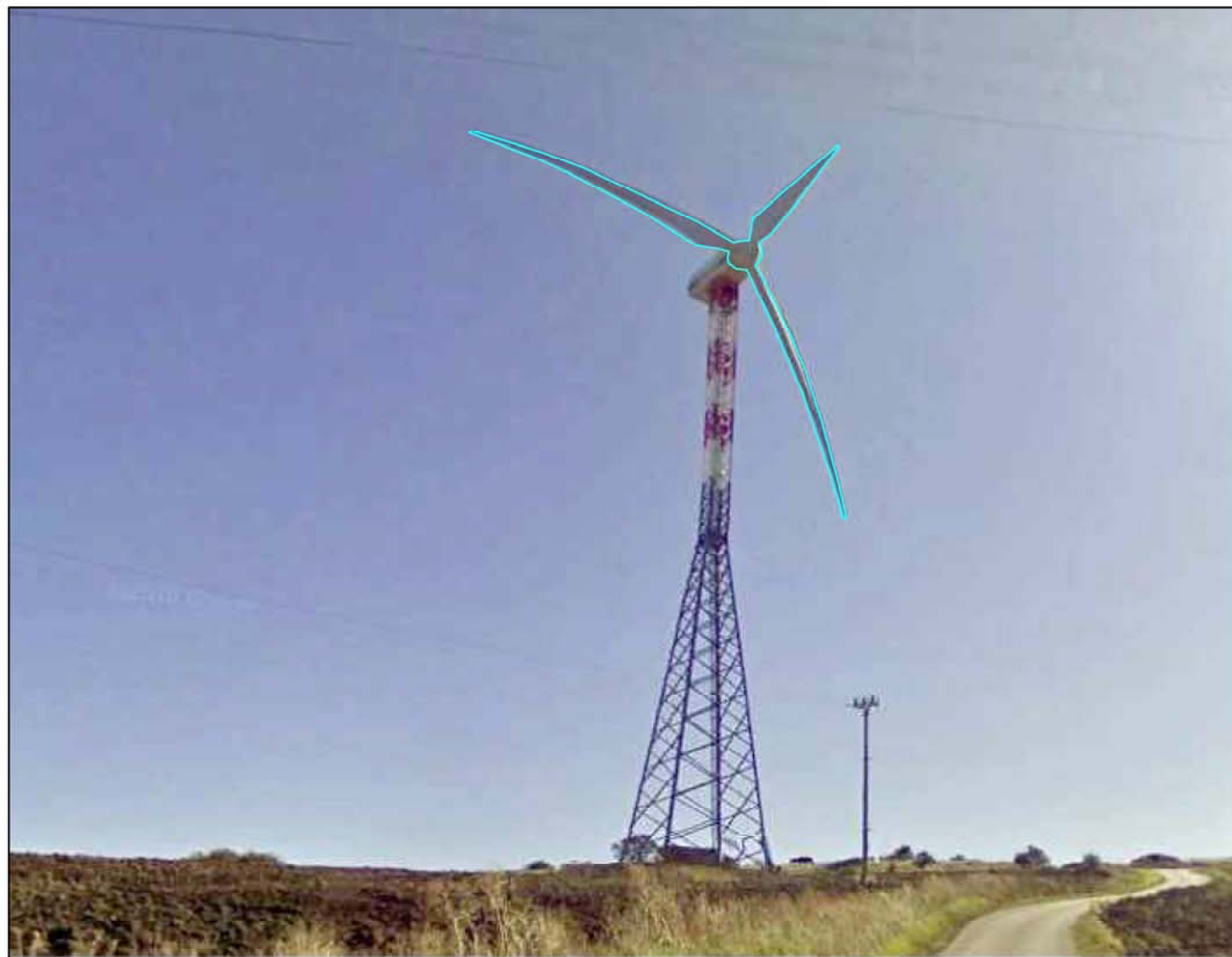
FOTO A – SITUAZIONE ANTE OPERAM: vista ravvicinata dell'aerogeneratore esistente con delimitazione delle sagome delle pale
