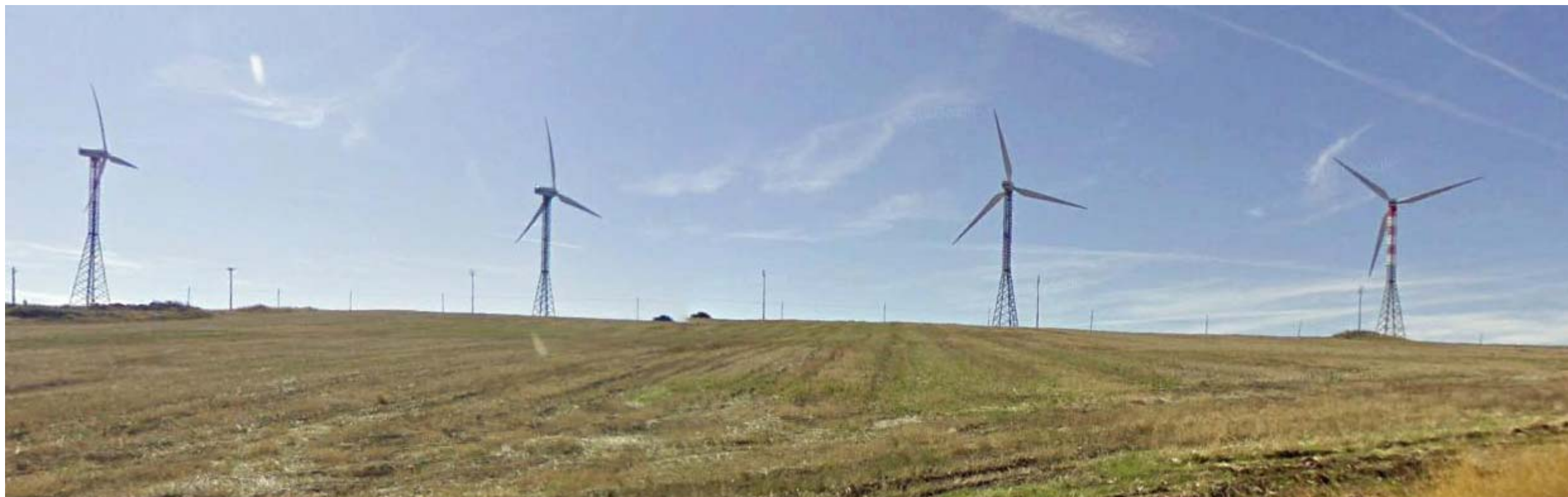
FOTO B – SITUAZIONE ANTE OPERAM: vista panoramica degli aerogeneratori esistenti
