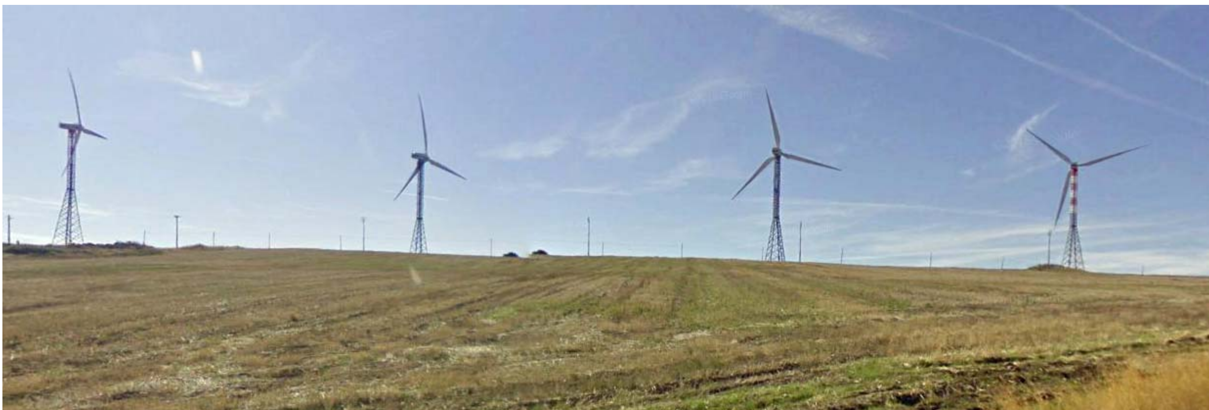
FOTO B – SITUAZIONE POST OPERAM: vista panoramica degli aerogeneratori oggetto di reblading, la maggiore lunghezza delle pale risulta impercettibile per visuali panoramiche
