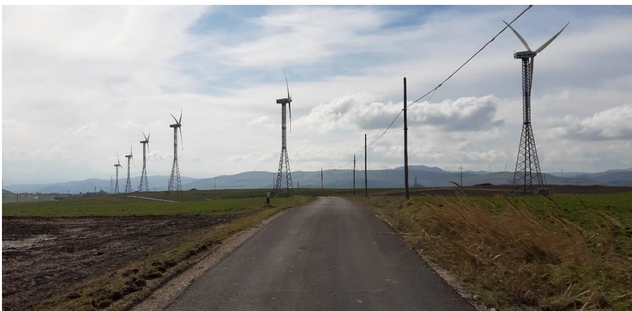
Strutture esistenti di tipologia a traliccio
