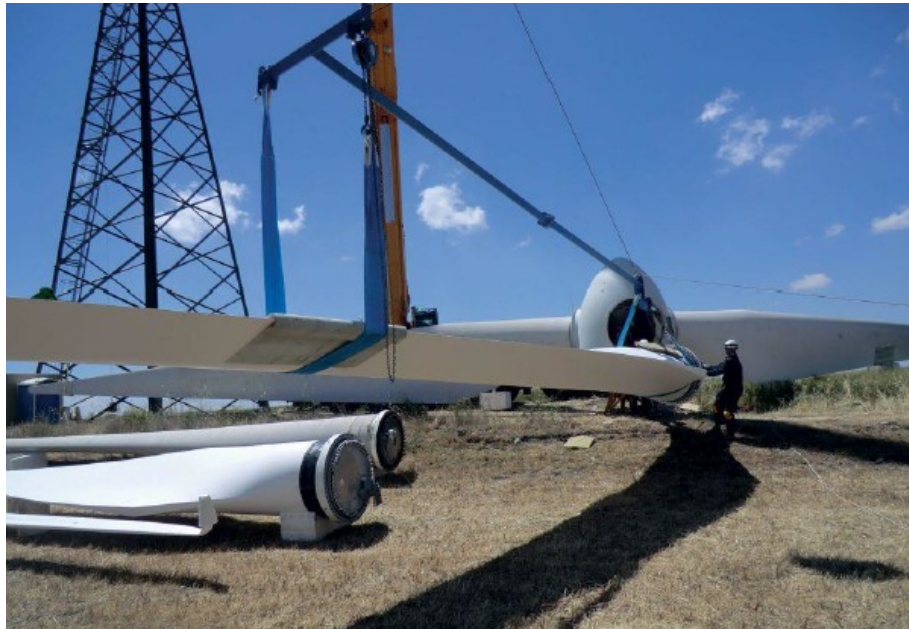
Figura 2: Esecuzione della sostituzione delle pale del rotore.
