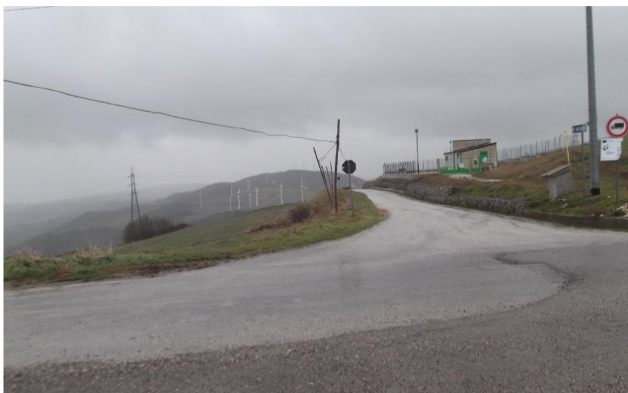
Figura 8: Ingresso da Sud –Strada comunale Staccia (presso turbina LC38)
