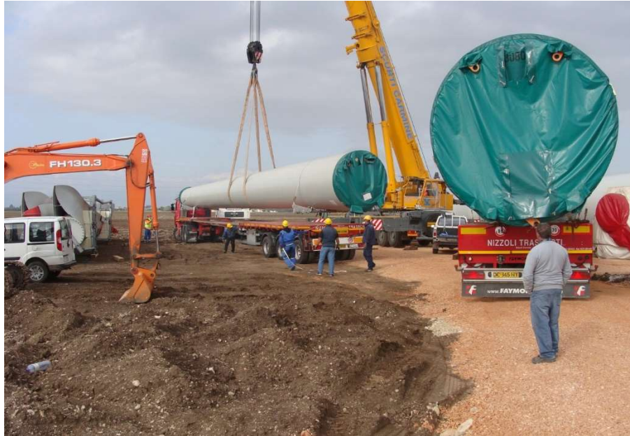
Figura 7: elementi torre smontata pronti per il trasporto
