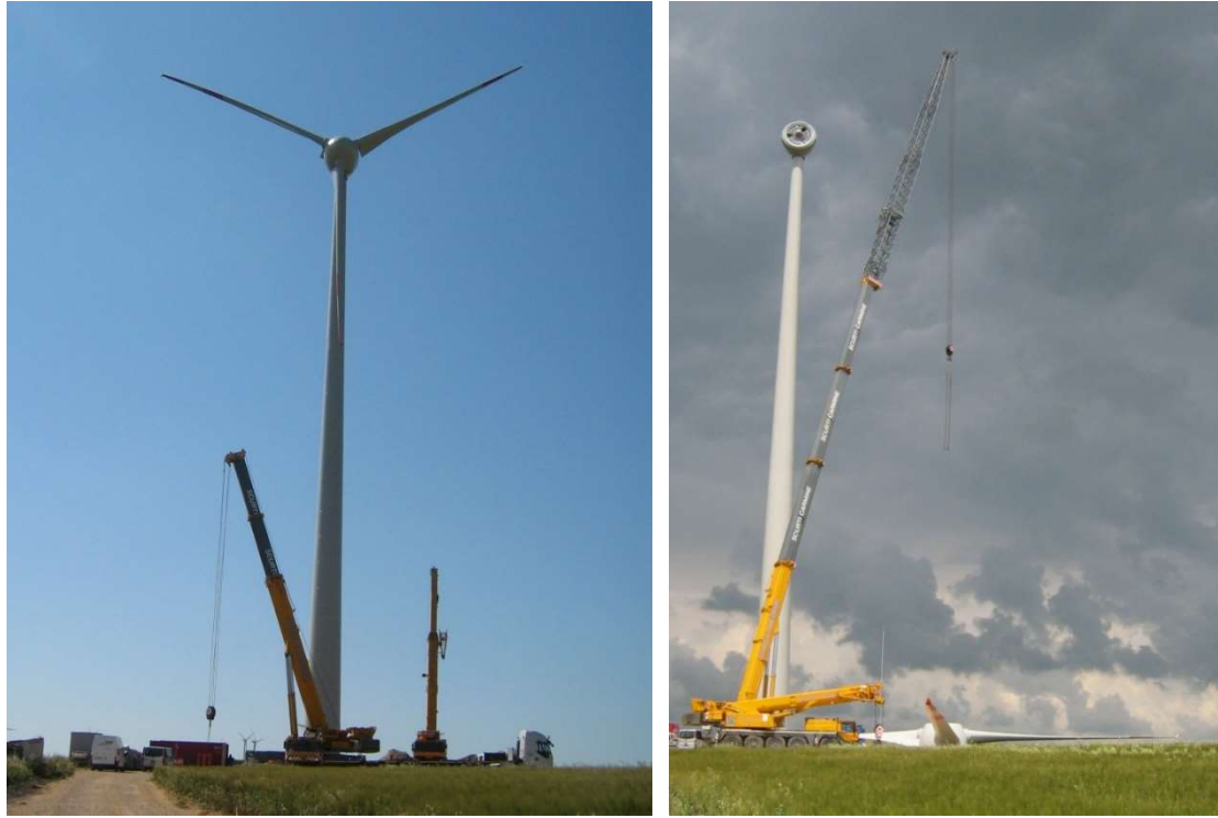
Figura 4: rimozione eliche e mozzo
