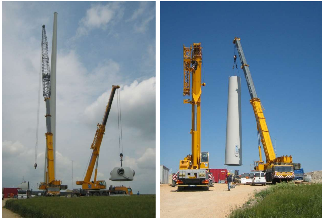
Figura 4: rimozione eliche e mozzo
