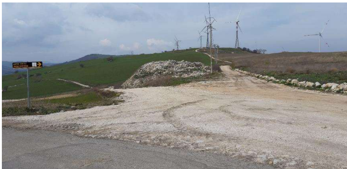
Figura 13. Vista panoramica e accesso IV tronco di aerogeneratori (da MV01 a MV09) da viabilità principale SP83
