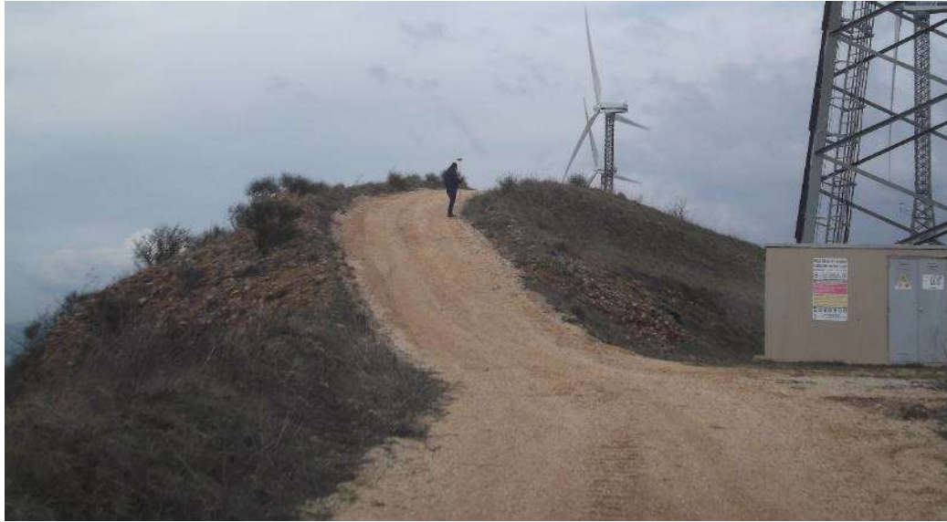
Figura 3. Vista strada interna al parco da aerogeneratore LC06 a LC07
