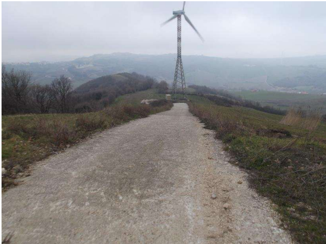
Figura 6. Vista strada cementata interna al parco a forte pendenza tra aerogeneratore LC24 e LC23
