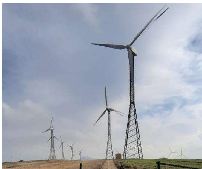
Figura 16. Vista panoramica IV tronco aerogeneratori da (MV01 a MV09)
