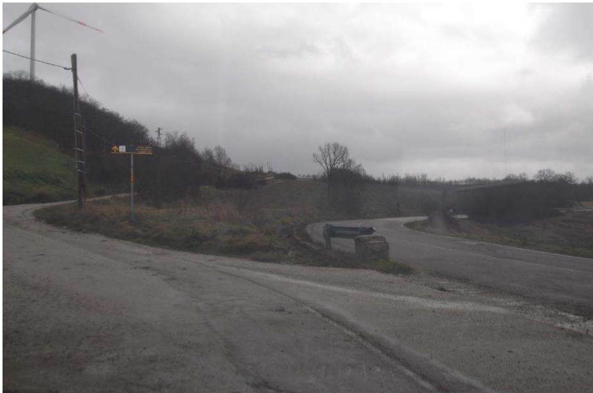
Figura 8. Accesso alternativo Il tronco di aerogeneratori (da LC30 a LC38) da viabilità principale SS399 (ingresso impianto ER Bisaccia-accesso Est) in direzione Sud dell'impianto
