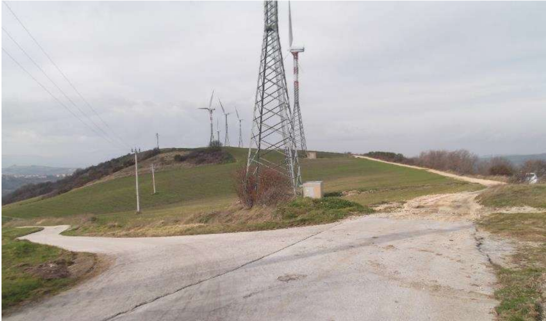
Figura 5. Accesso e vista Il tronco di aerogeneratori (da LC23 a LC29) da viabilità comunale loc. Pauroso
