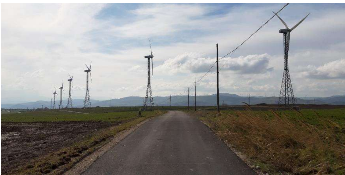
Figura 10. Vista III tronco di aerogeneratori (da LC39 a LC47) da viabilità comunale interna al parco
