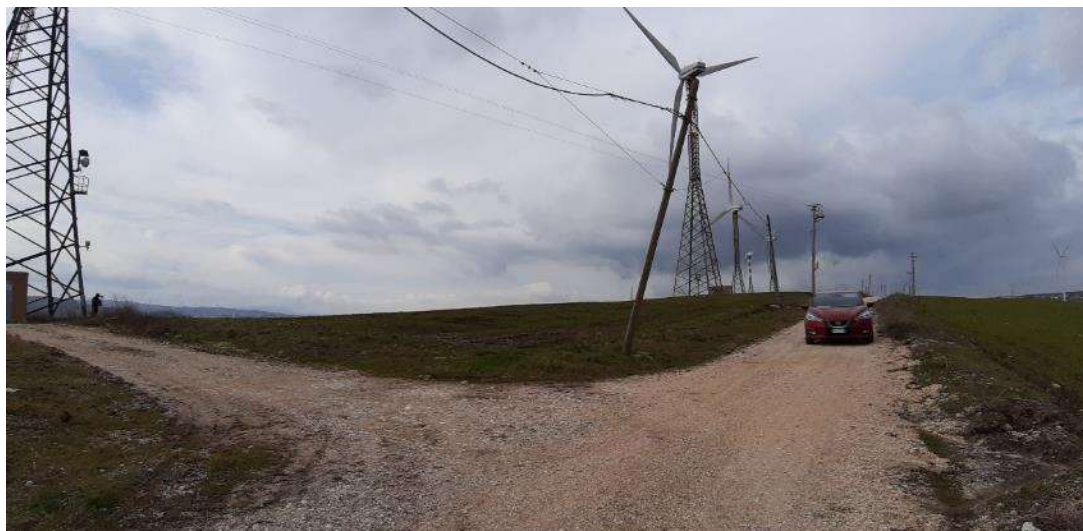
Figura 12. Vista strada interna al parco da aerogeneratore LC50 a LC54
