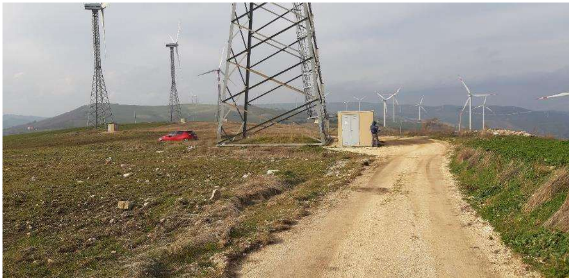
Figura 15. Vista panoramica aerogeneratori MV04 e, sullo sfondo, MV03, MV02 e MV01
