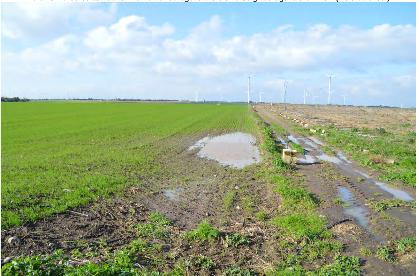
Foto 17. Percorso cavidotto interno verso l'aerogeneratore 8 (vista da est)
