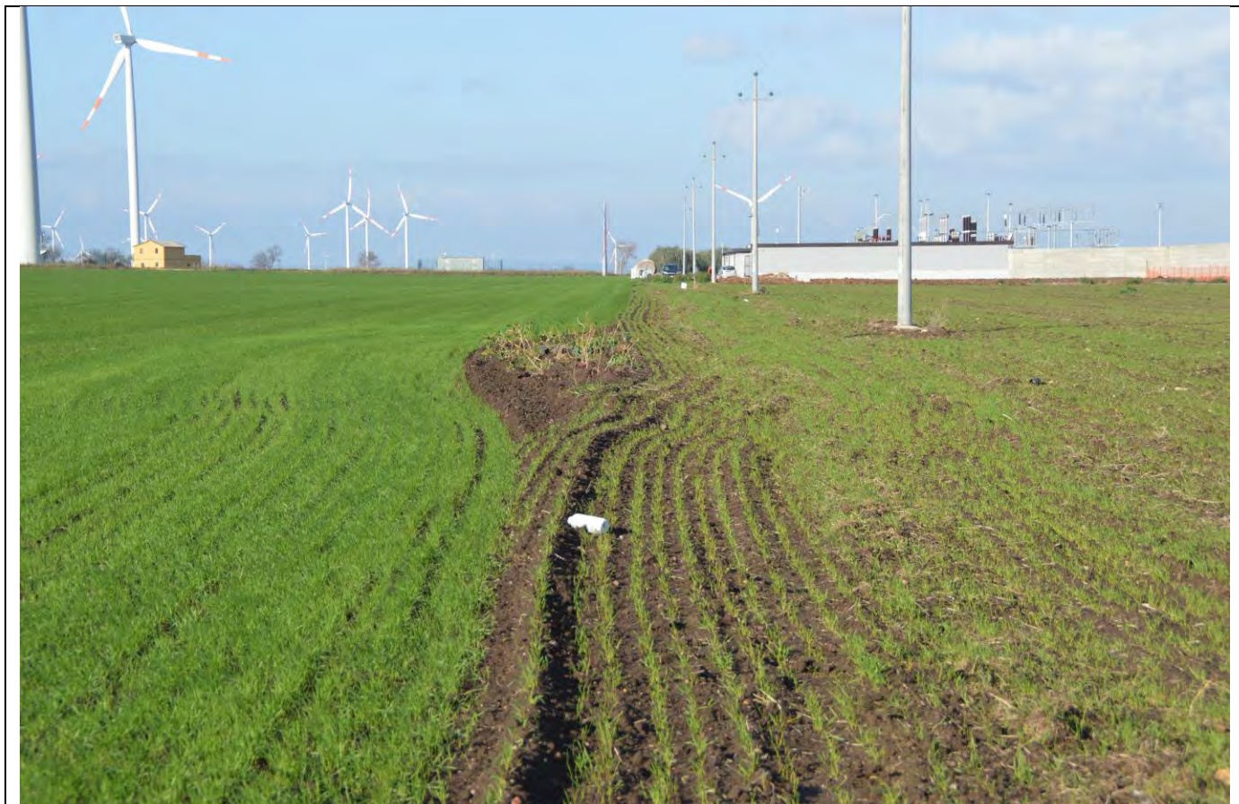
Foto 1. Area della sottostazione e percorso cavidotto esterno (vista da est)
