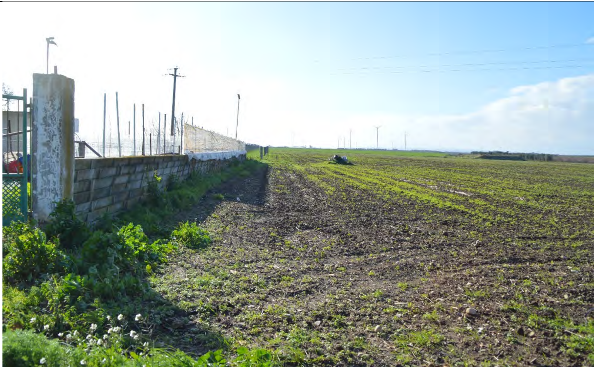
Foto 38. Percorso del cavidotto interno nei pressi dell'aerogeneratore 4 (vista da NE)
