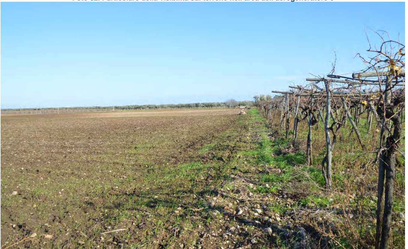
Foto 33. Percorso del cavidotto interno tra gli aerogeneratori 6 e 7 (vista da ovest)
