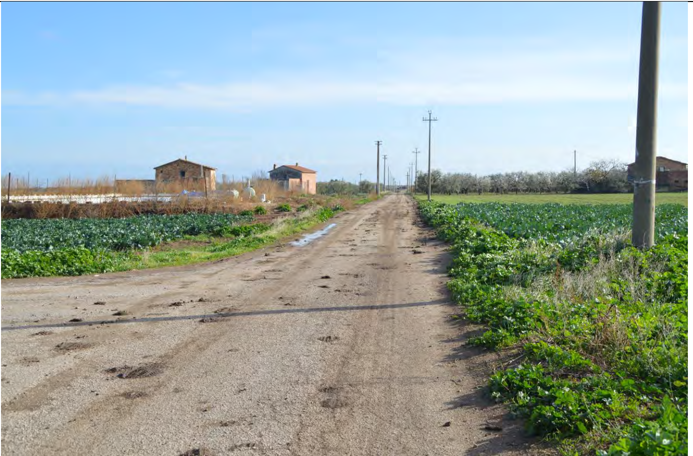
Foto 16. Percorso cavidotto interno dall'aerogeneratore 8 verso gli aerogeneratori 7 e 4 (vista da ovest)
