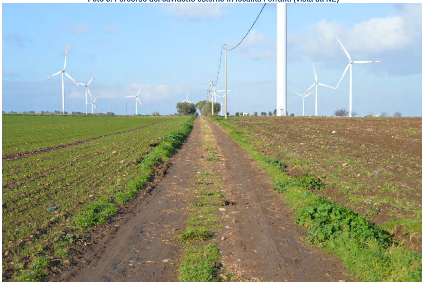
Foto 6. Percorso cavidotto esterno in località Ferranti verso la Marana Santo Spirito (vista da E)
