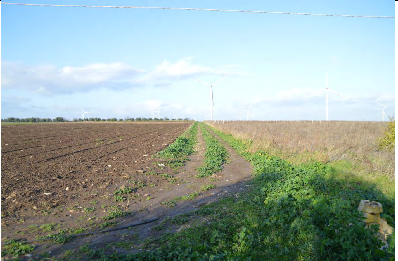
Foto 7. Percorso cavidotto esterno nei pressi della Marana Santo Spirito
