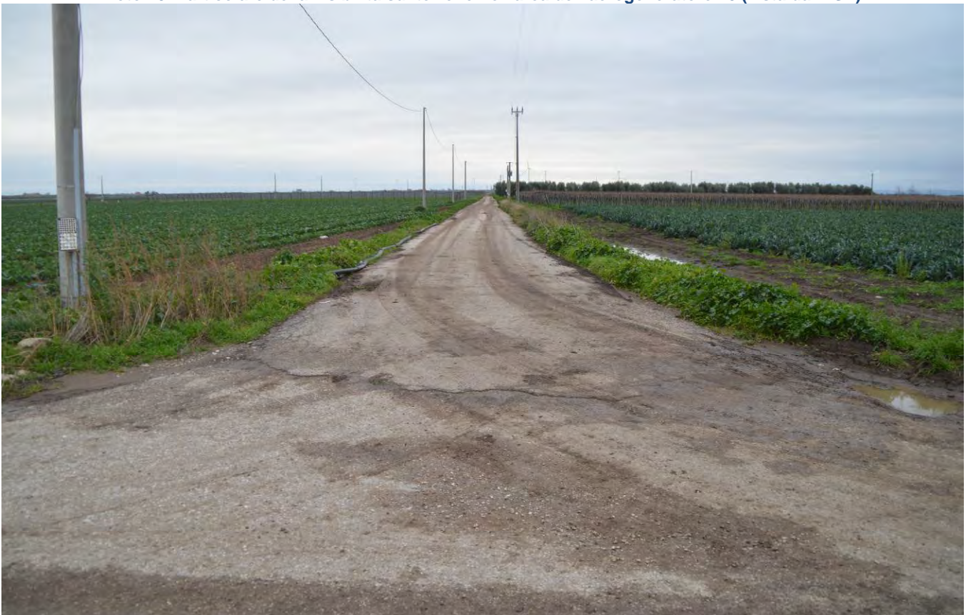
Foto 11. Il percorso del cavidotto interno tra gli aerogeneratori 10 e 9 vista da nord dal Regio Trattarello Cerignola-Ponte Bovino, verso la strada vicinale Novelli
