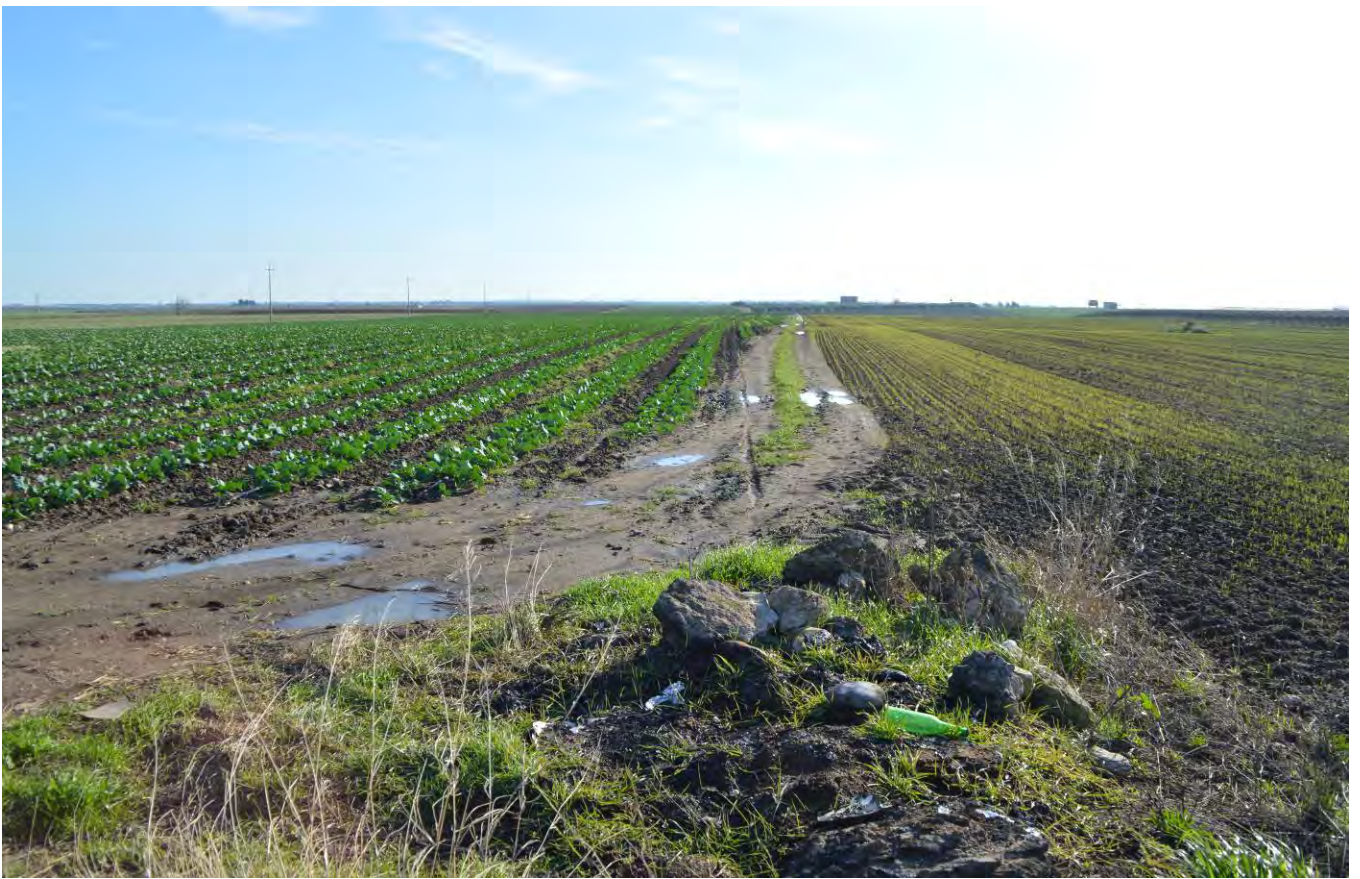
Foto 20. Percorso cavidotto interno aerogeneratore 1 (vista da ovest)
