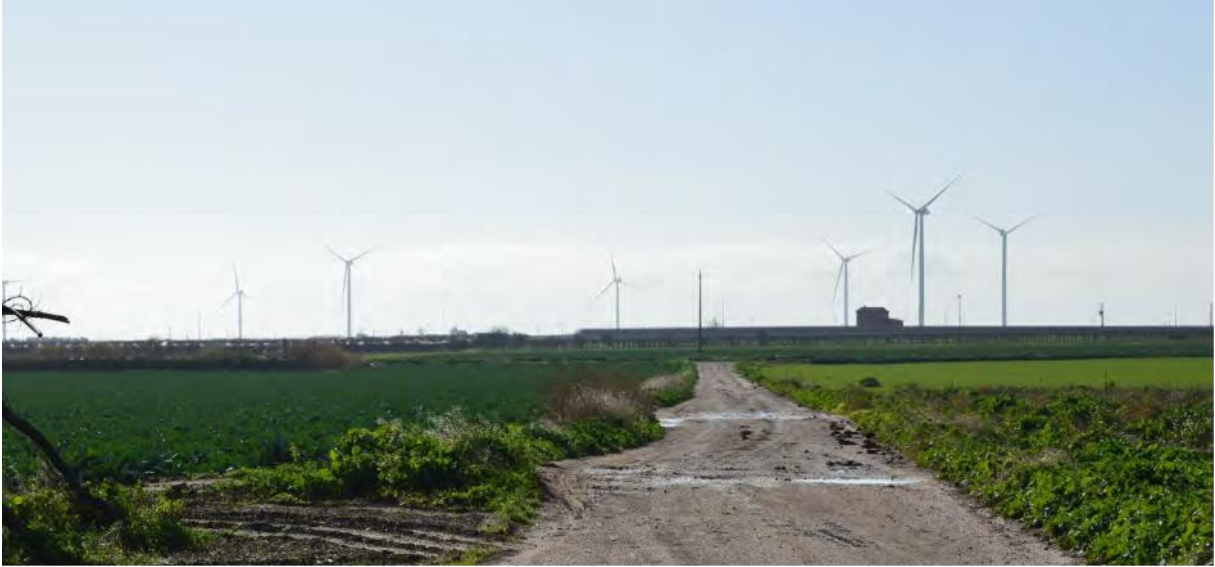
Foto P2.2: Vista della strada, interessato dal passaggio del cavidotto interno di collegamento tra WTG9– WTG8
