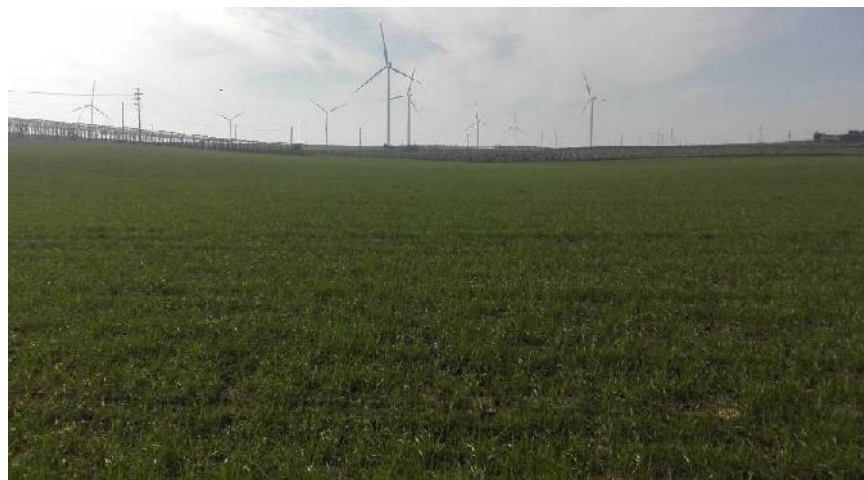
Foto P6.3: Vista del reticolo secondario segnalato nelle Carta Idrogeomorfologica (inesistente) (lato monte) Nella vista sono visibili gli aerogeneratori di Stornarella
