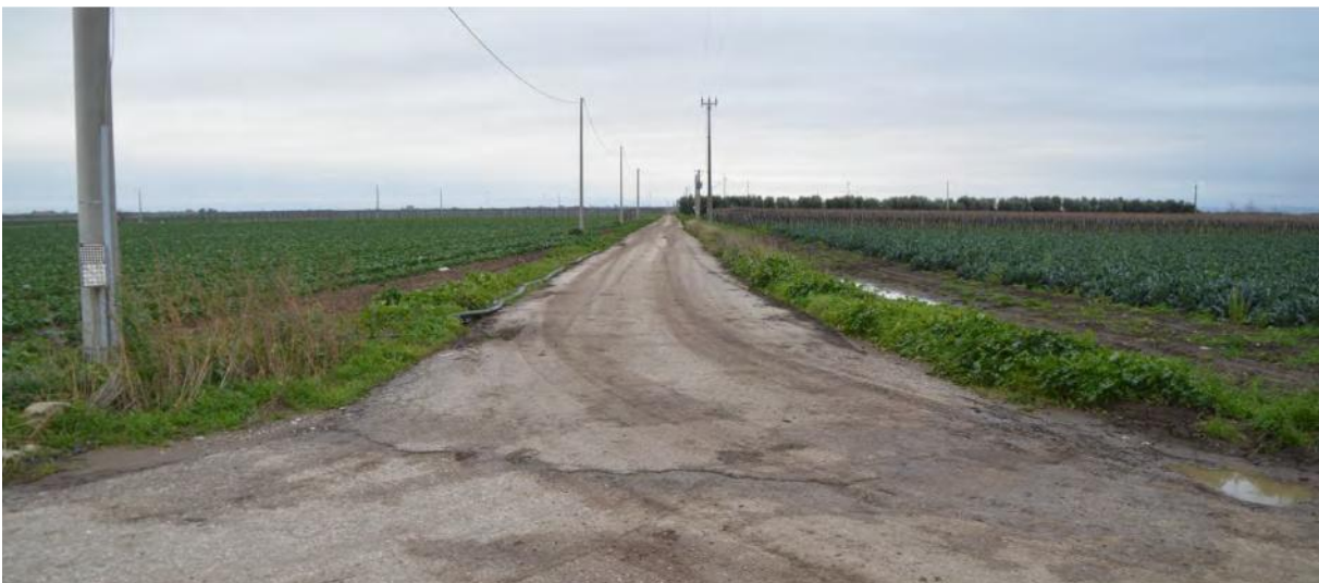
Foto P2.1: Vista della strada, interessato dal passaggio del cavidotto interno di collegamento tra WTG10 – WTG8
