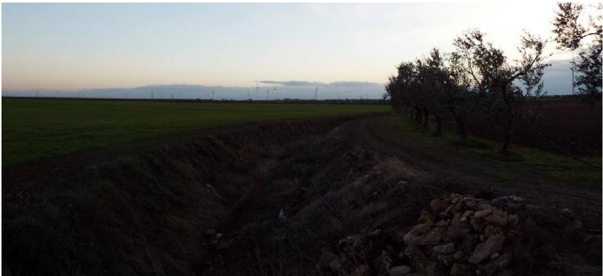
Foto P1.5: Canale Santo Spirito/Ponticello, lungo la strada vicinale Ordonà – Stornara, in direzione sud, in fondo si rilevano gli aerogeneratori presenti nel territorio di Orta Nova
