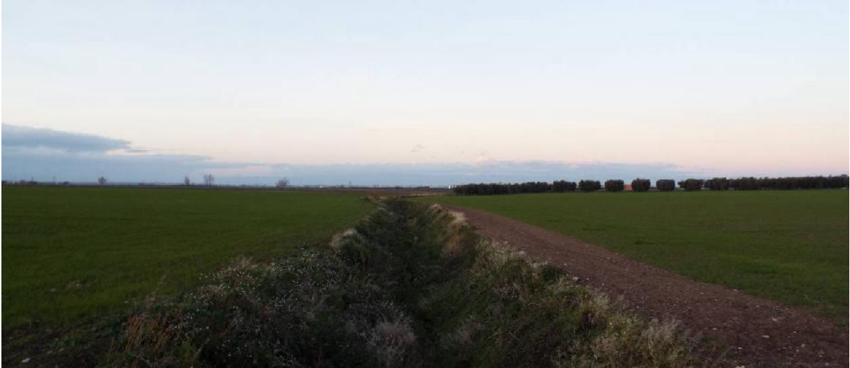
Foto P1.1: Canale Santo Spirito/Ponticello, lungo la strada vicinale Ordonà – Stornara, in direzione nord
