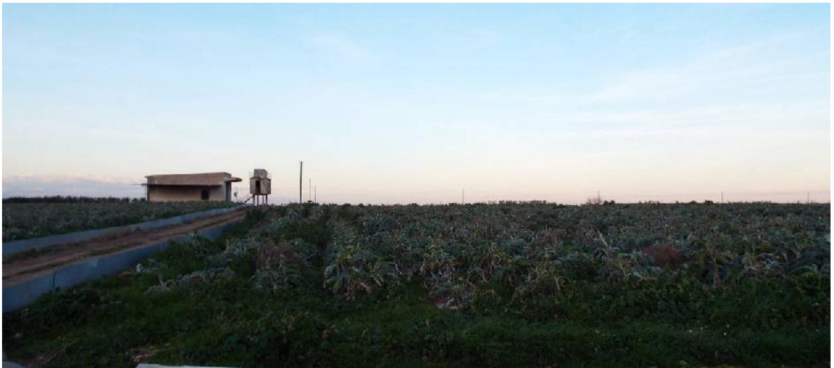
Foto P7.2: Vista dell'area di installazione degli aerogeneratori WTG2
