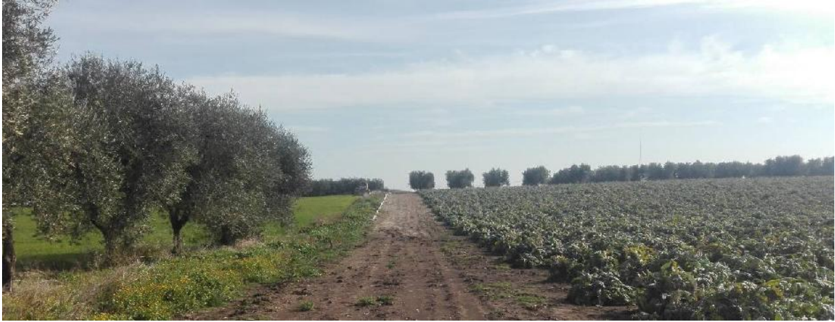
Foto P2.5: Vista della strada, interessato dal passaggio del cavidotto interno di collegamento alla WTG7, in prossimità del reticolo secondario segnalato nelle Carta I drogeomorfologica (inesistente)
