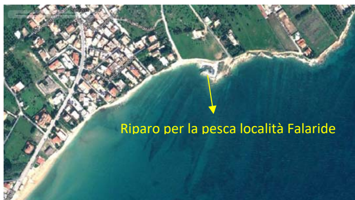
Figura 2.1: Ortofoto anno 2003 in assenza delle opere di cui ai lavori delle opere di difesa a salvaguardia della linea di costa di 1° e 2° stralcio
