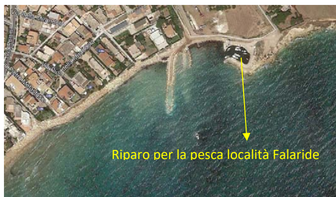
Figura 2.2.b: Ortofoto anno 2016 con eseguiti i lavori di difesa costiera di 1° stralcio ed in corso di esecuzione i lavori di difesa costiera di 2° stralcio
