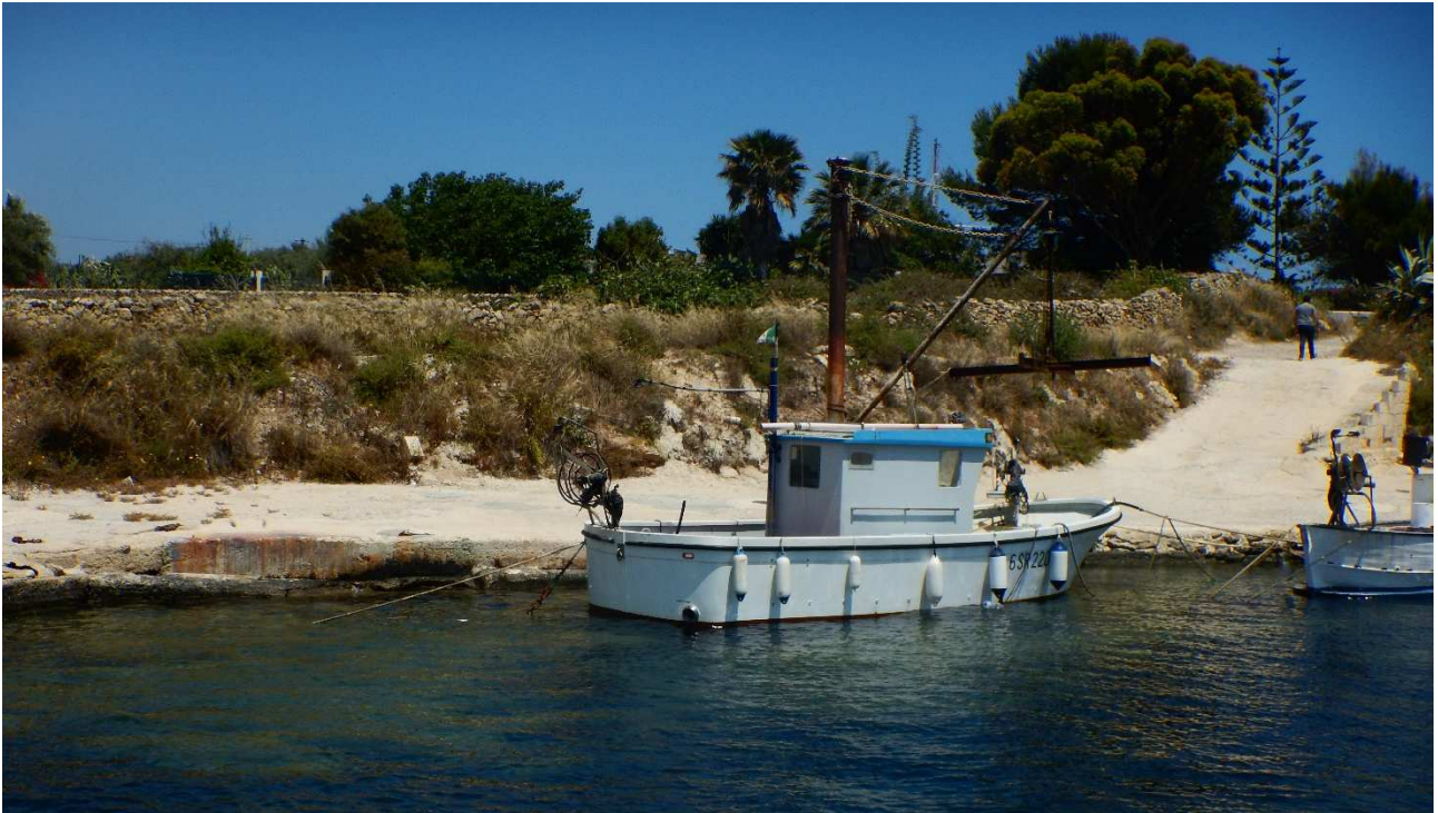
Fig. 21: Stato ante operam - banchina nord ed ingresso riparo (foto).
