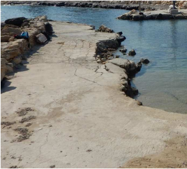
Figura 4: Stato di deterioramento della struttura di banchina
