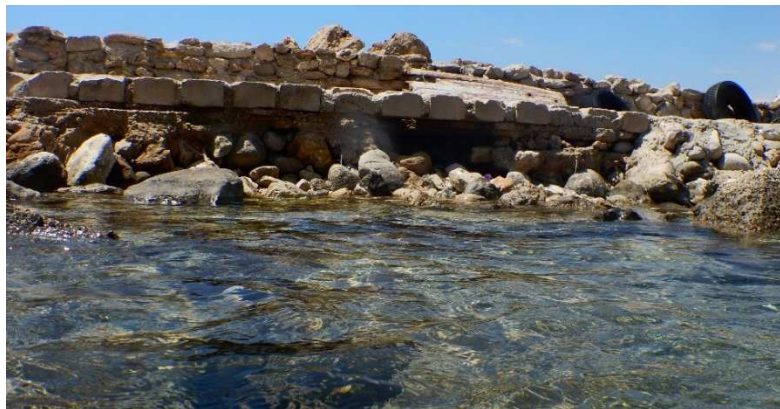
Figura 4: Stato di deterioramento della struttura di banchina
