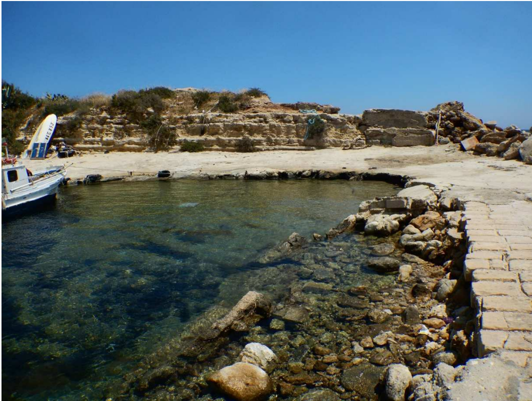
Fig. 19: Stato ante operam - banchina est e molo di sopraflutto (foto)
