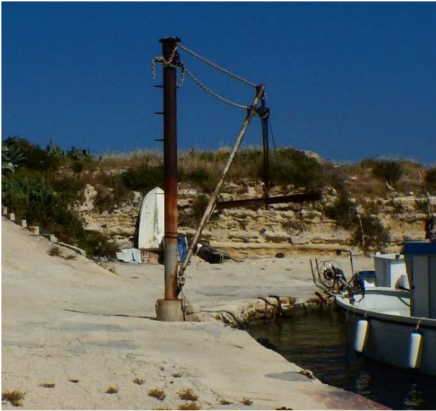
Figura 6: Deterioramento degli arredi di banchina
