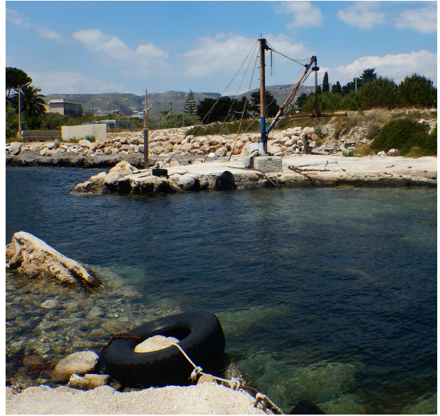
Figura 6: Deterioramento degli arredi di banchina
