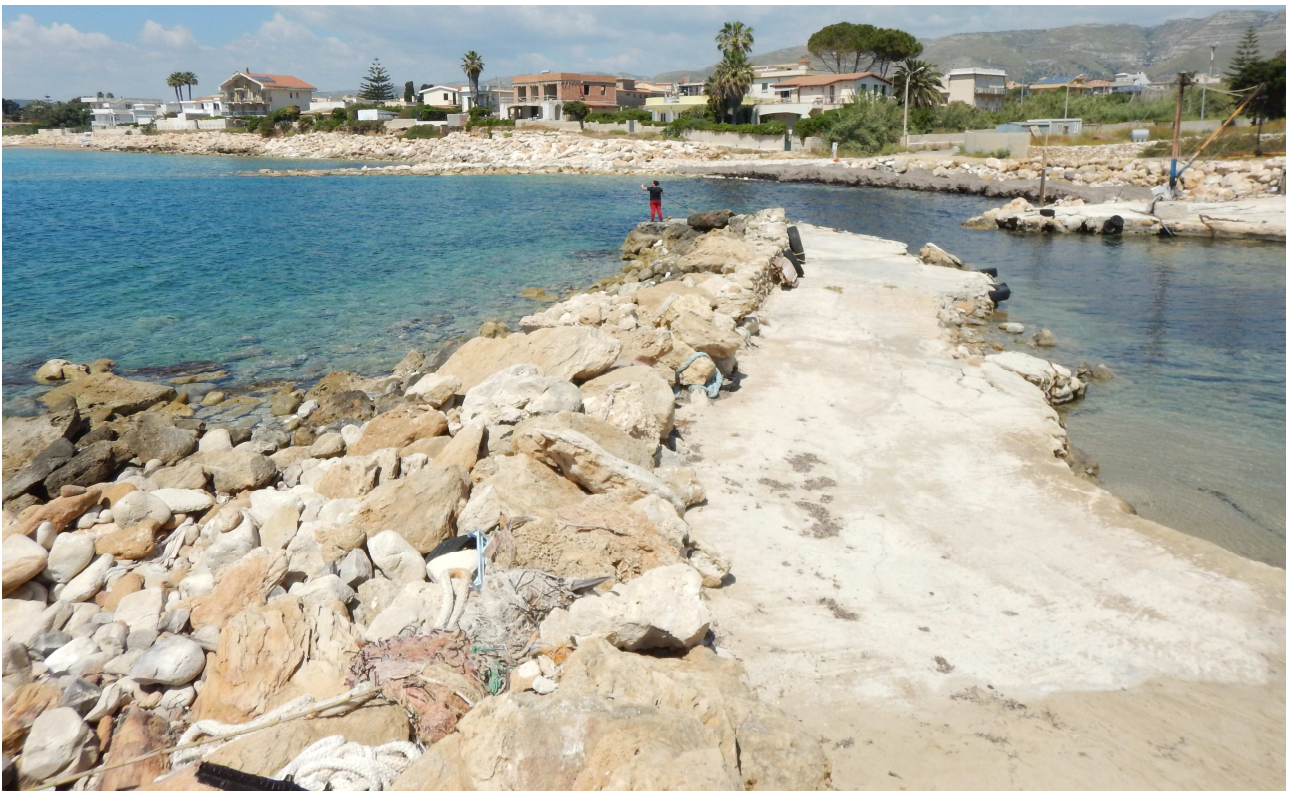
Figura 7: Massi naturali a protezione del bacino interno
