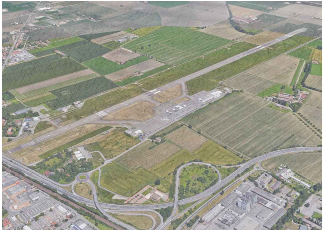
Piazzola deicing area cargo e unità di trattamento acque di dilavamento
