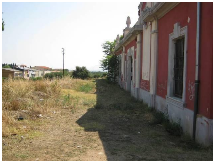
Area dove sorgerà la nuova strada
