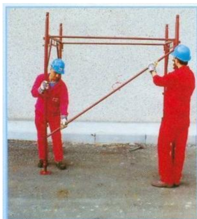
4 Inserimento della diagonale in vista e del parapetto doppio
