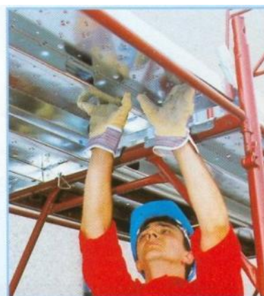
9 Realizzazione nuovi piani di lavoro
