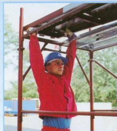
6 Inserimento delle tavole metalliche
