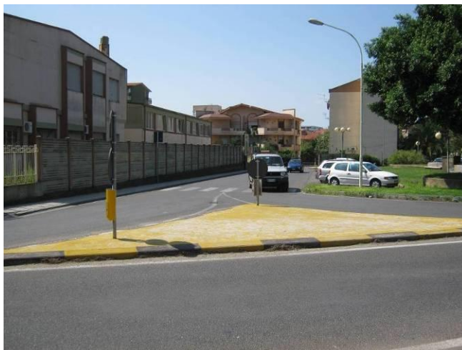
Spartitraffico da demolire
