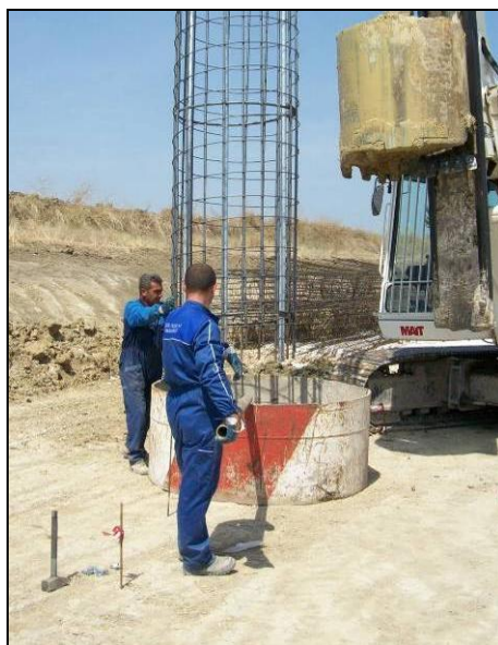
Infilaggio armatura all'interno del foro
