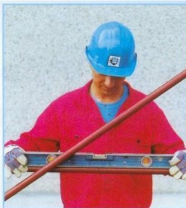
5 Verifica planarità della struttura
