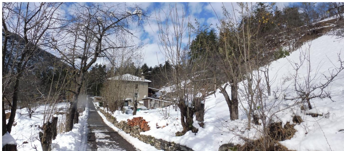
Figura 16 - PUNTO VISUALE P.11 - Vista dall'abitato di Royeres verso l'area di intervento (non visibile). L'edificio a destra della strada è quello più prossimo alle aree di cantiere.
