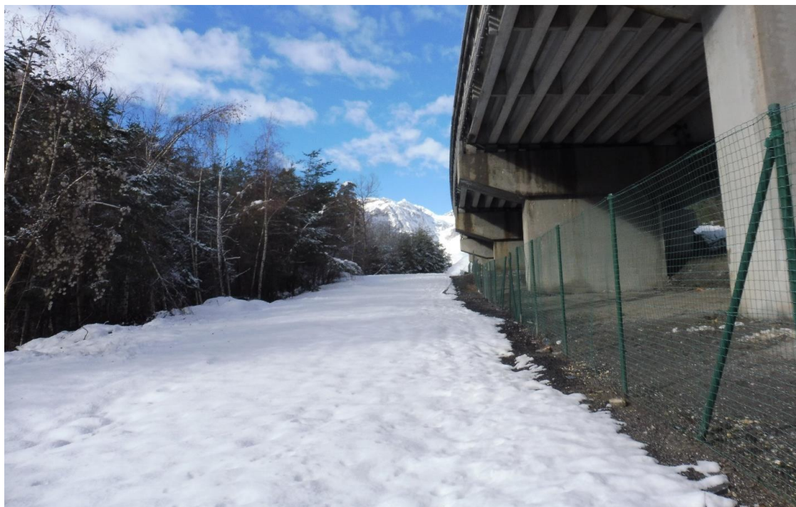
Figura 9 - PUNTO VISUALE P.04 - Vista verso ovest del viadotto esistente e della fascia libera adibita a cantiere
