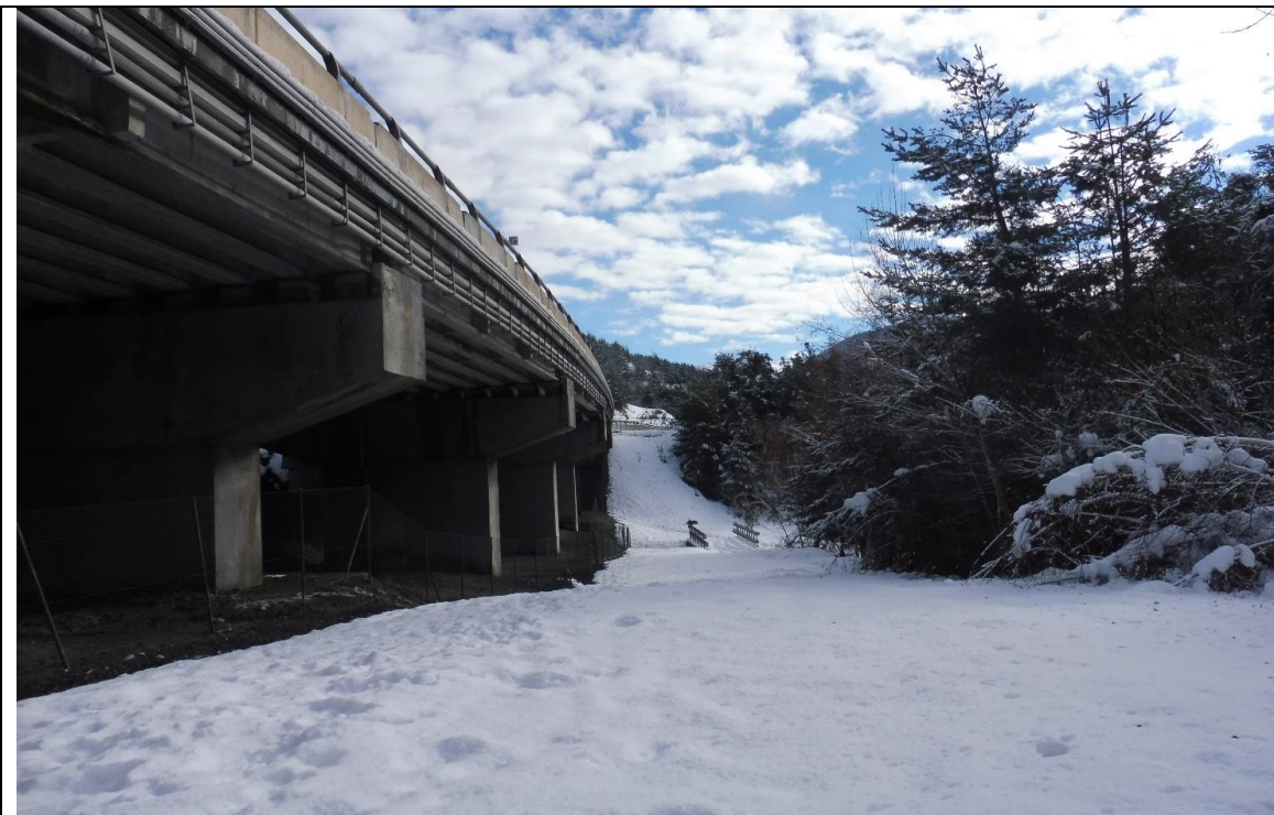
Figura 10 - PUNTO VISUALE P.05 - Vista verso est del viadotto esistente e della fascia libera adibita a cantiere
