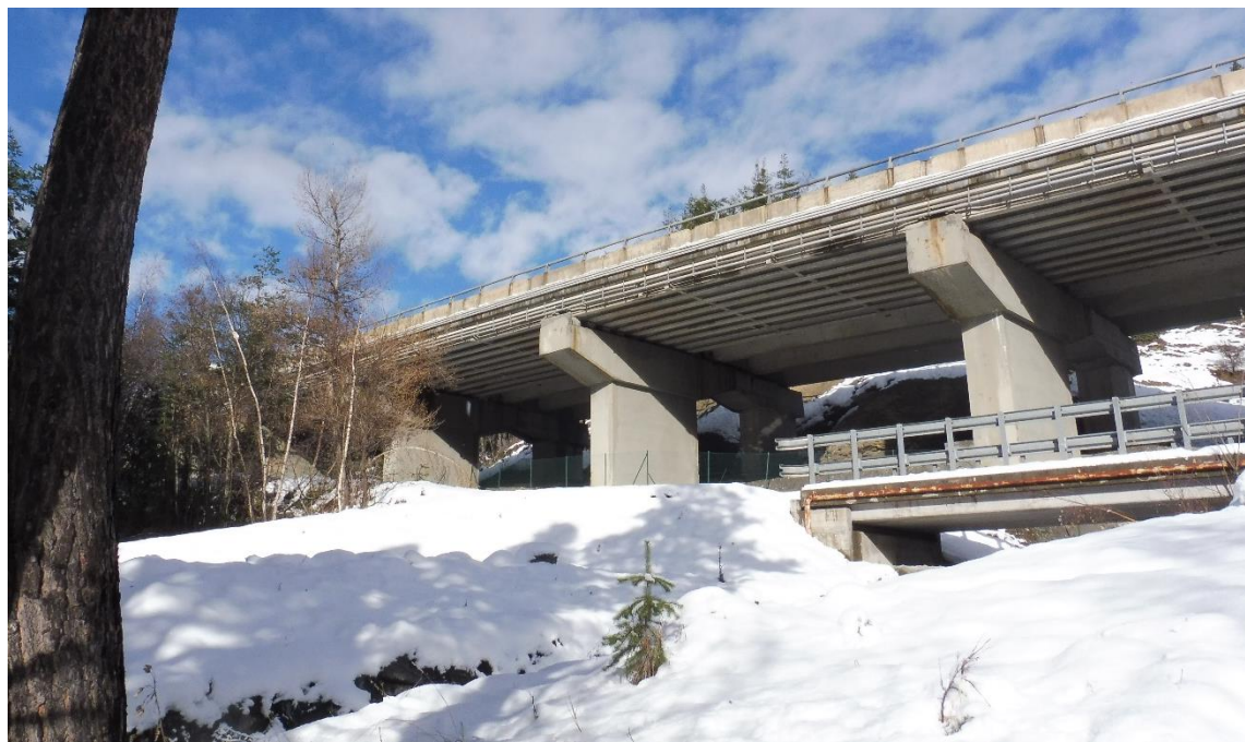
Figura 7 - PUNTO VISUALE P.02 - Vista dalla viabilità di cantiere verso nord-ovest sul viadotto in esame
