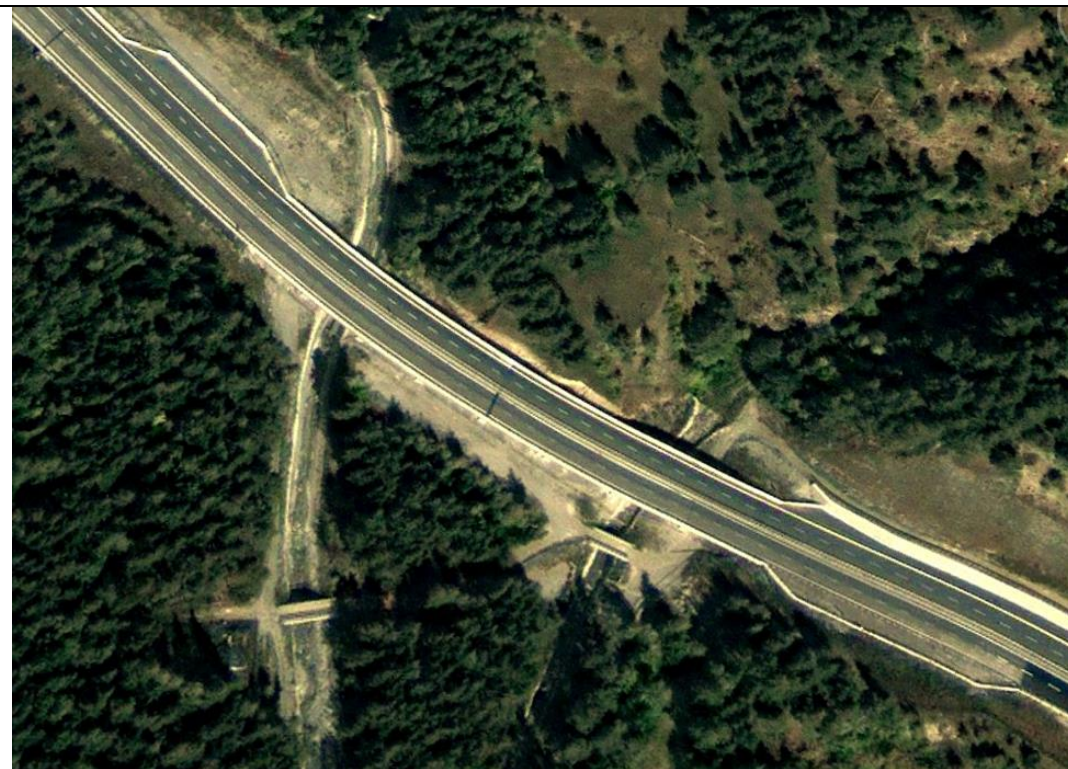
Figura 4 – Dettaglio del viadotto oggetto di adeguamento. È ben visibile la fascia libera da vegetazione lungo la carreggiata di discesa, che sarà utilizzata in fase di cantiere.
