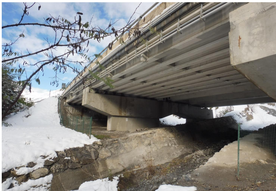
Figura 11 - PUNTO VISUALE P.06 - Vista verso ovest del viadotto esistente nell'attraversamento del rio Perilleux
