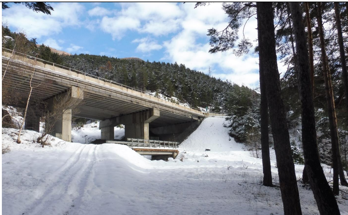
Figura 14 - PUNTO VISUALE P.09 - Vista verso nord-est del viadotto nell'attraversamento del rio Combe Ferane
