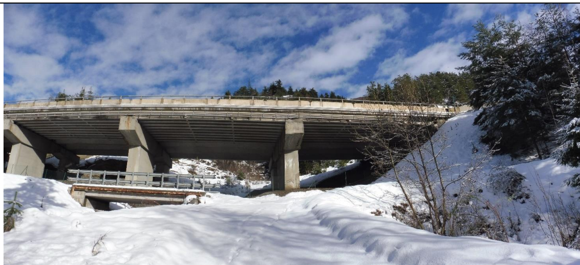
Figura 6 - PUNTO VISUALE P.01 - Vista dalla viabilità di cantiere verso nord sul viadotto esistente
