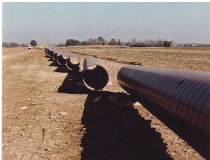
Figura 3: Esempio di sfilamento tubazioni
