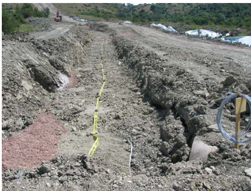
Figura 7: Esempio di rinterro della condotta
