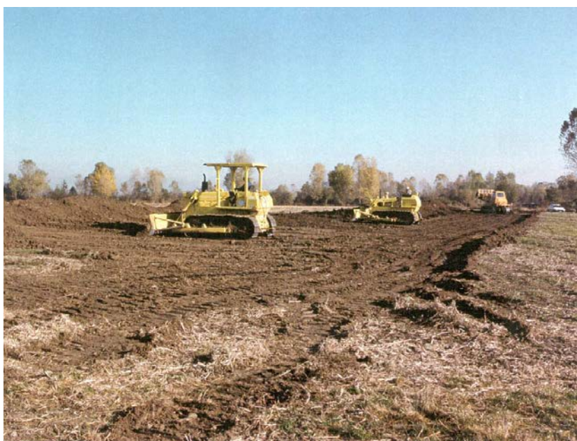
Figura 2: Esempio di apertura dell’area di passaggio
