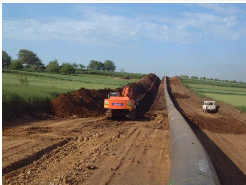
Figura 5: Esempio di scavo in trincea
