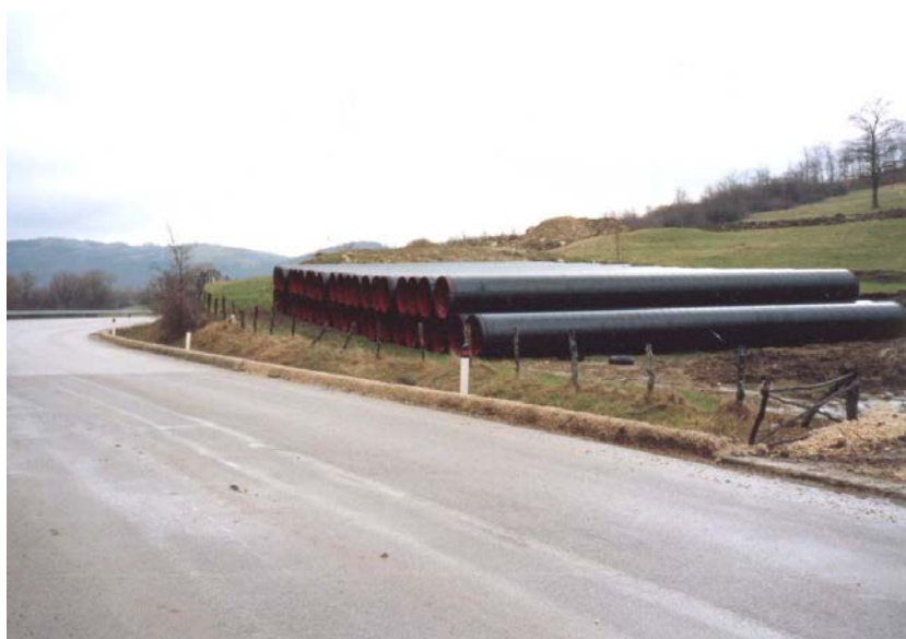
Figura 1: Esempio di piazzola di accatastamento tubazioni
