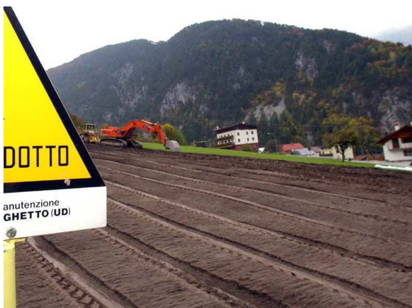
Figura 8: Esempio di redistribuzione dello strato superficiale
