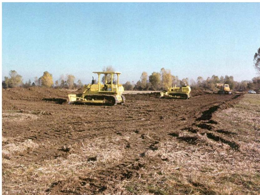
**Fig. 3.1.B: Esempio di apertura dell'area di passaggio**
