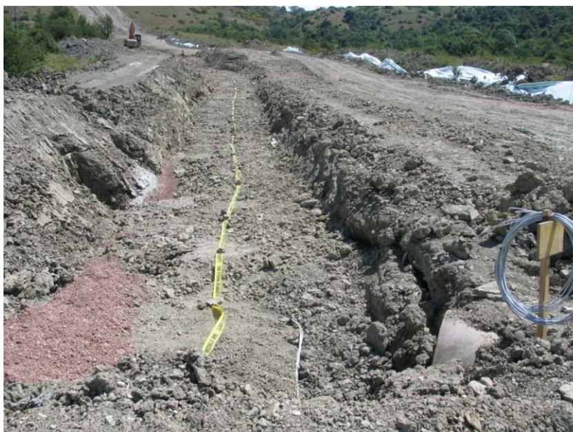
**Fig. 3.1.G: Esempio di rinterro della condotta**
