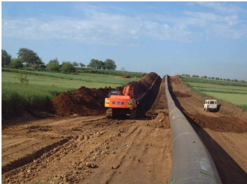
**Fig. 3.1.E: Esempio di scavo in trincea**
