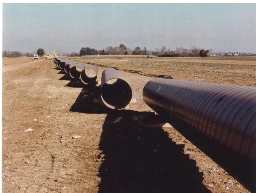
**Fig. 3.1.C: Esempio di sfilamento tubazioni**
