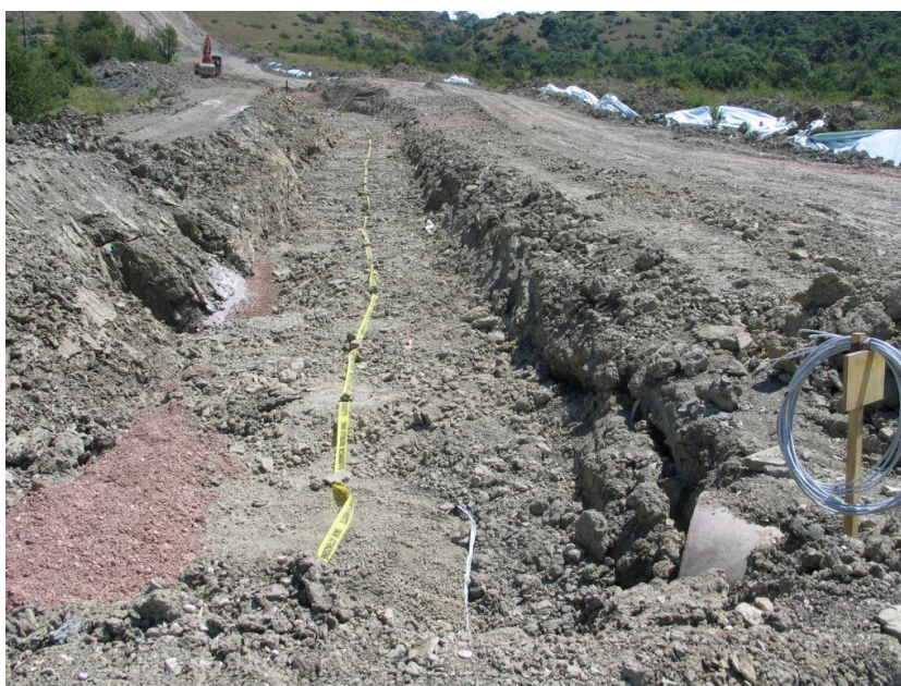
Fig. 2/E: Esempio di rinterro della condotta
