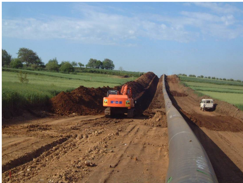
Fig. 2/C: Esempio di scavo in trincea
