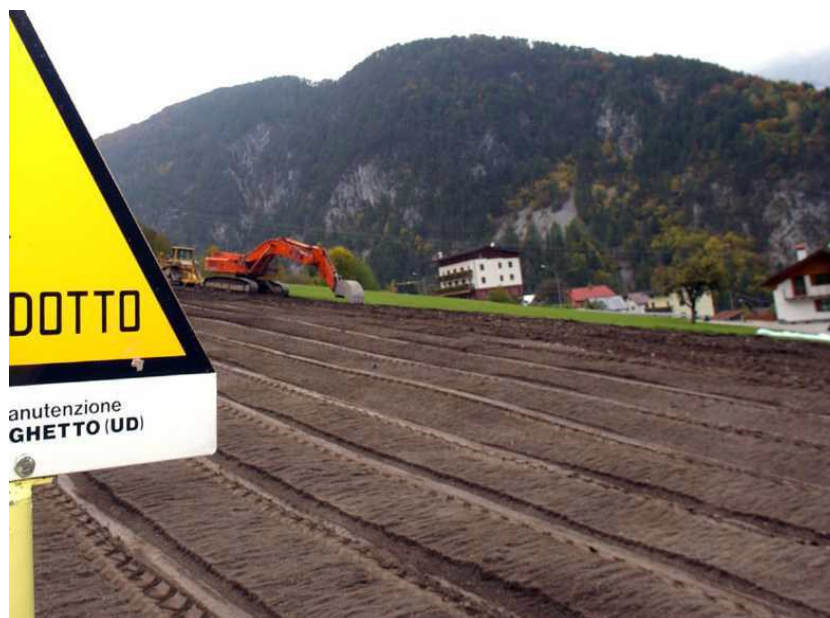
Fig. 2/F: Esempio di redistribuzione dello strato humico
