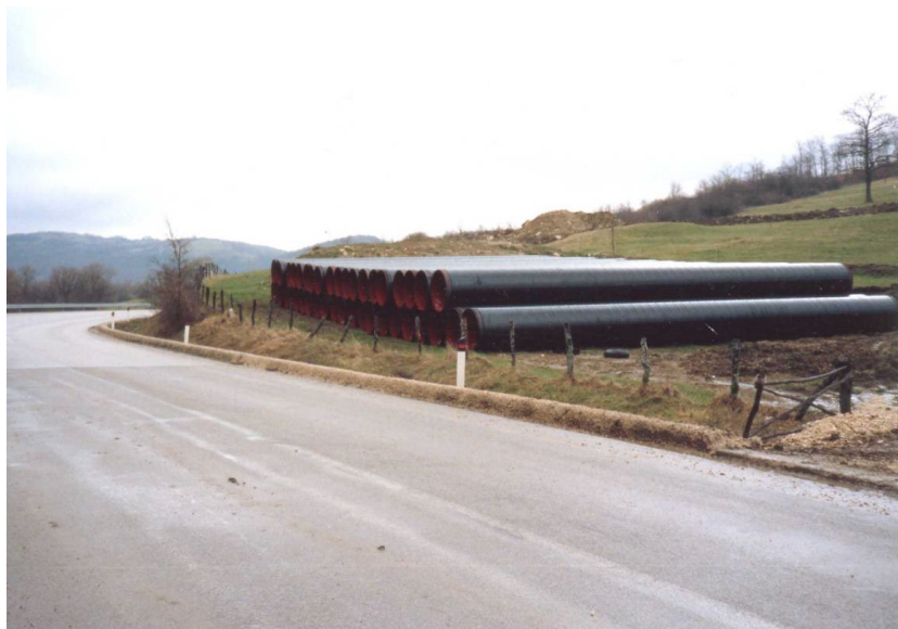
Fig. 2/A: Esempio di piazzola di accatastamento tubazioni
