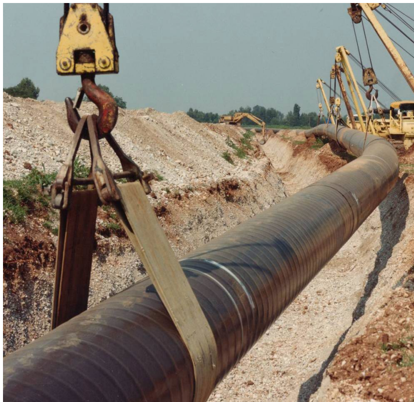
Fig. 2/D: Esempio di posa della condotta
