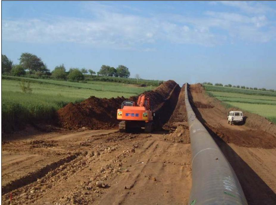
Fig. 3.1.E: Esempio di scavo in trincea
