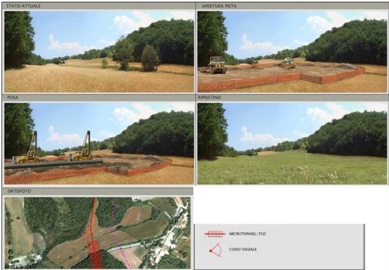
Fig. 3.1.I: Simulazione di lavori tipici di un tratto di posa trenchless
