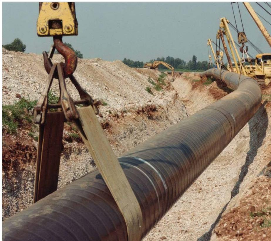
Fig. 3.1.F: Esempio di posa della condotta
