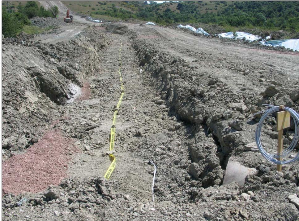
Fig. 3.1.G: Esempio di rinterro della condotta
