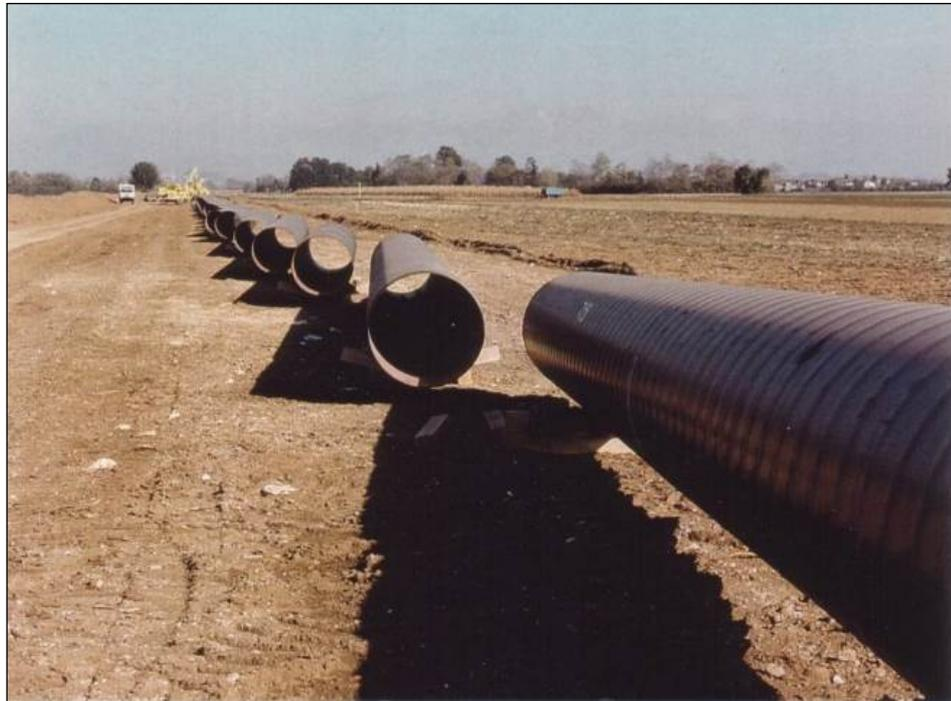
Fig. 3.1.C: Esempio di sfilamento tubazioni
