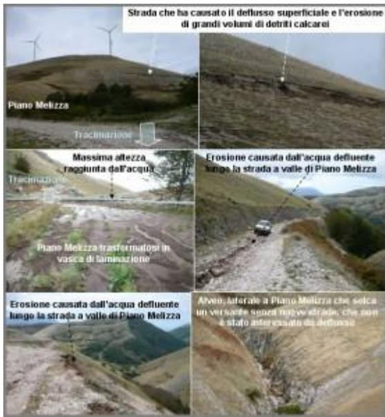
Figura 4: Esempio di inadeguata realizzazione di strade che
