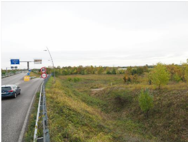
IMMAGINE 05 -ANTE OPERAM: VISTA DA INIZIO RAMPA TANGENZIALE SUD DI BERGAMO
