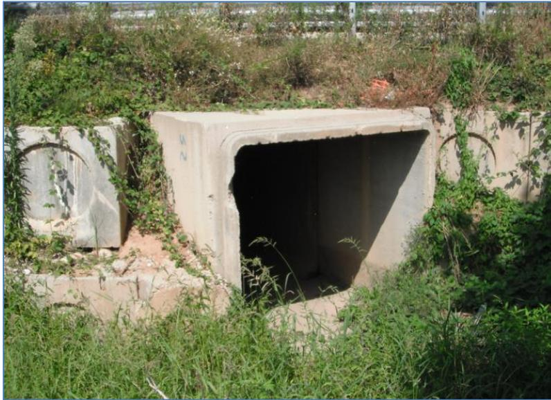
**Figura 19 – Scatolare esistente sotto la rotatoria della tangenziale Sud, oggetto di prolungamento**
