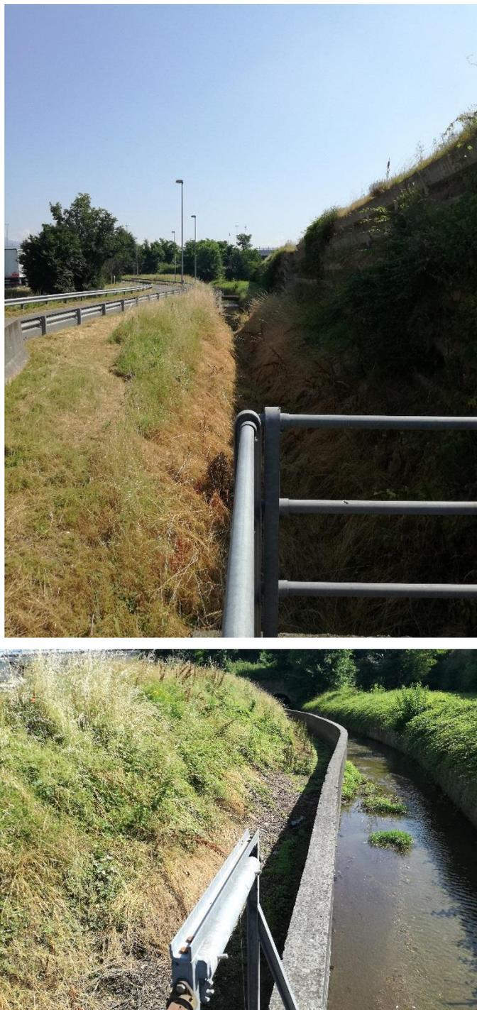
**Figura 16 – Fosso irriguo privato esistente tra la tangenziale Sud e l'attraversamento autostradale esistente – tratti oggetto di adeguamento (nuova canaletta di progetto)**
