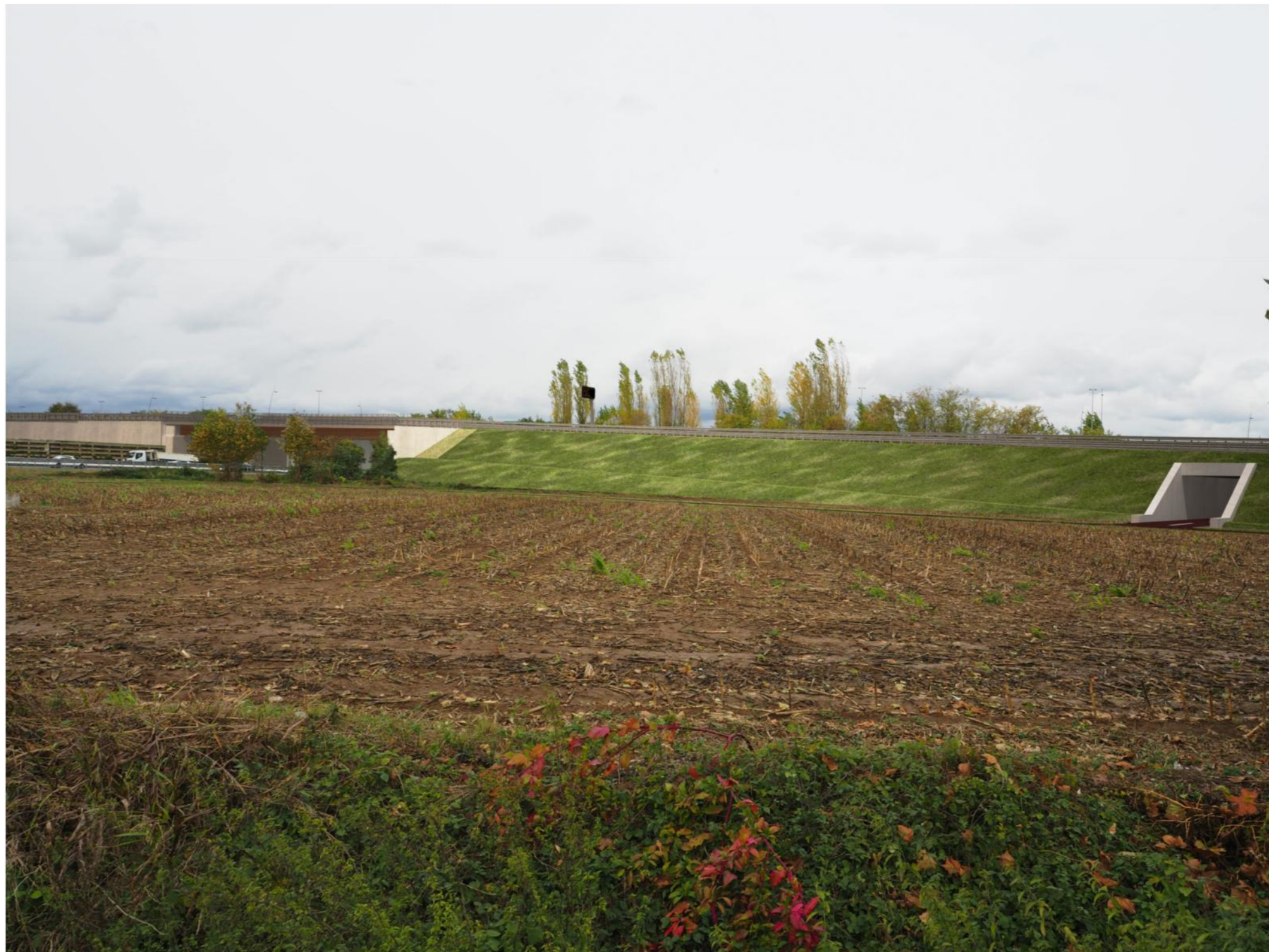
IMMAGINE 08 -POST OPERAM: VISTA DA LATO SABBIO BERGAMASCO
