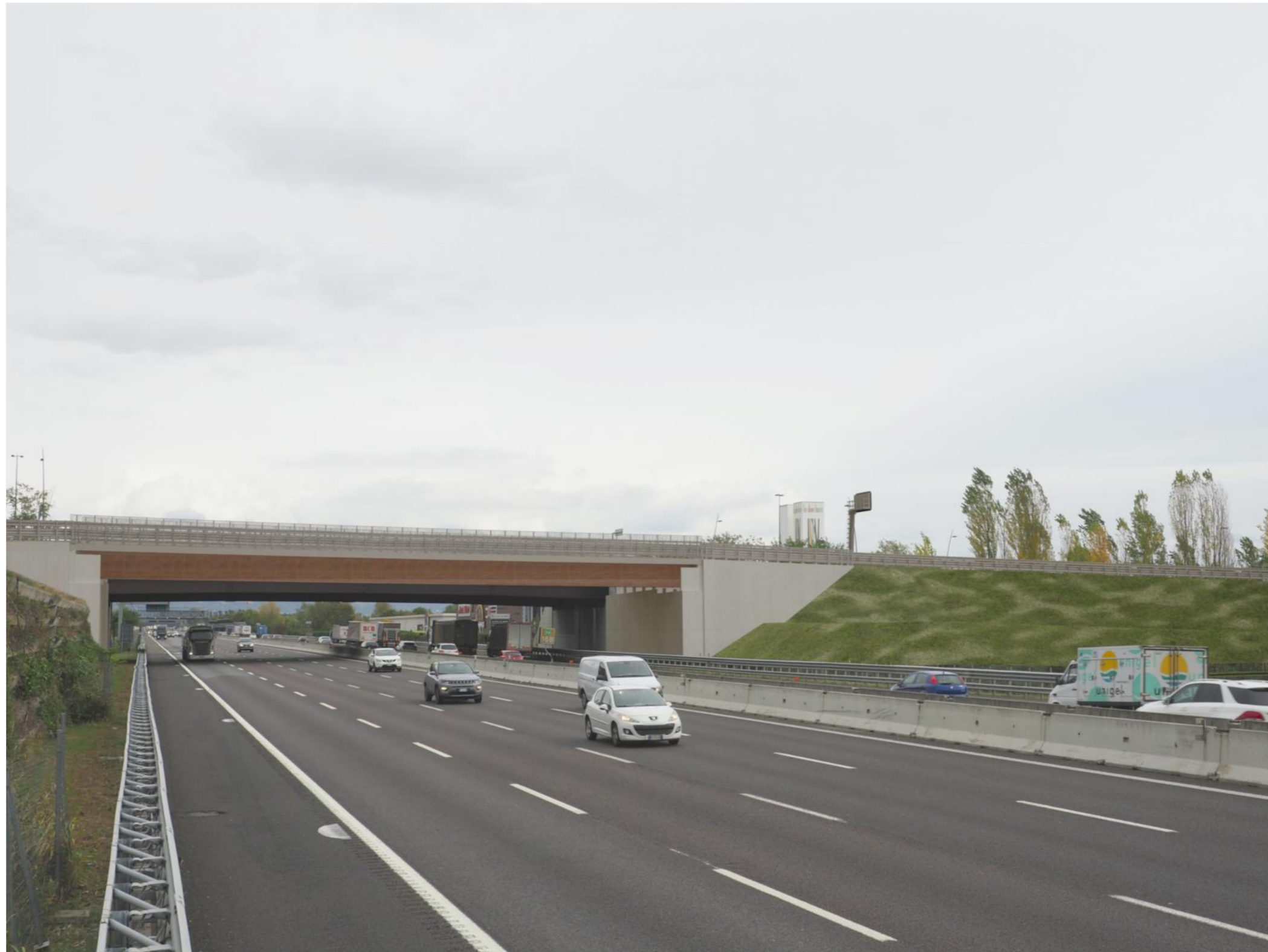
IMMAGINE 02 -POST OPERAM: VISTA DA AUTOSTRADA A4 TORINO- TRIESTE
