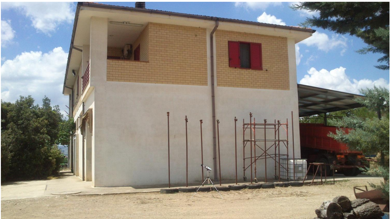
Figura 7: proprietà Lomurno - posizione del fonometro e vista dell'edificio adibito ad abitazione e ad azienda agricola; RICETTORE N.
