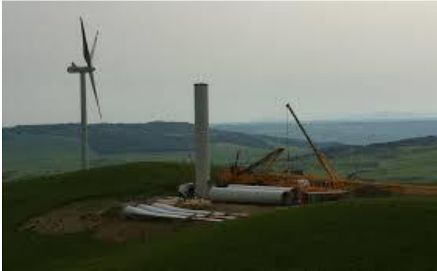
Figura 1_Piazzola di montaggio
