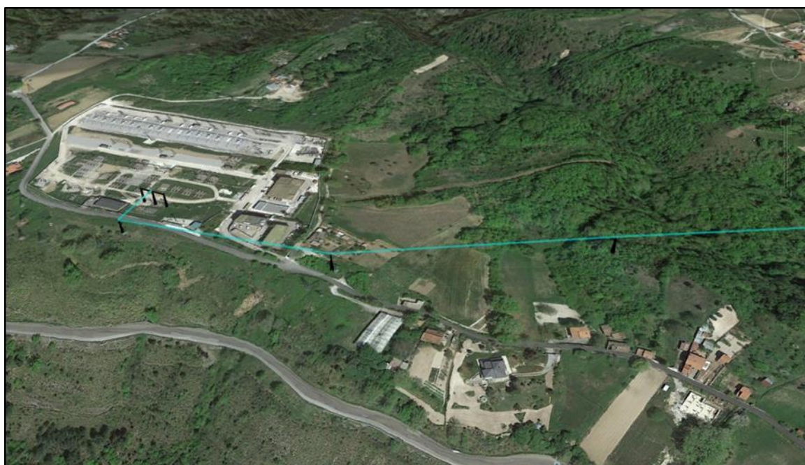
Figura 2 - Interventi di cui al punto 2. Linea AT in uscita dalla stazione lato Sud-Ovest
