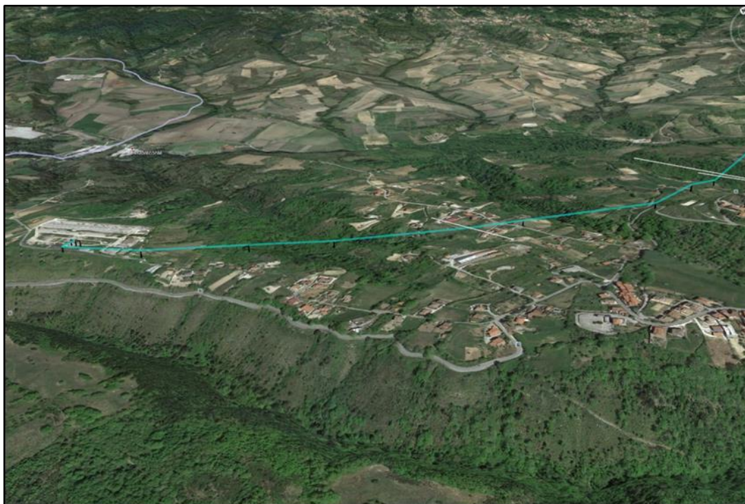
Figura 8 - Vista dell'attuale linea elettrica 150 kV ex Agri-Rotonda
