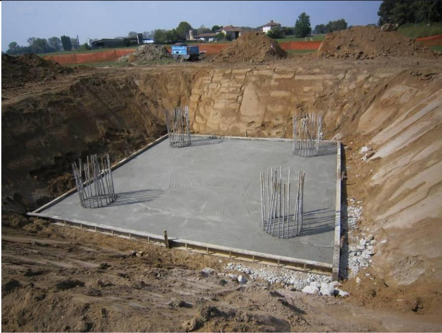
**Figura 22 - Realizzazione di una fondazione su pali trivellati per un sostegno monostelo.**
