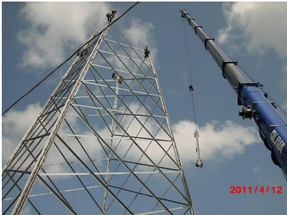
**Figura 28 - Fasi di montaggio sostegno a traliccio**
