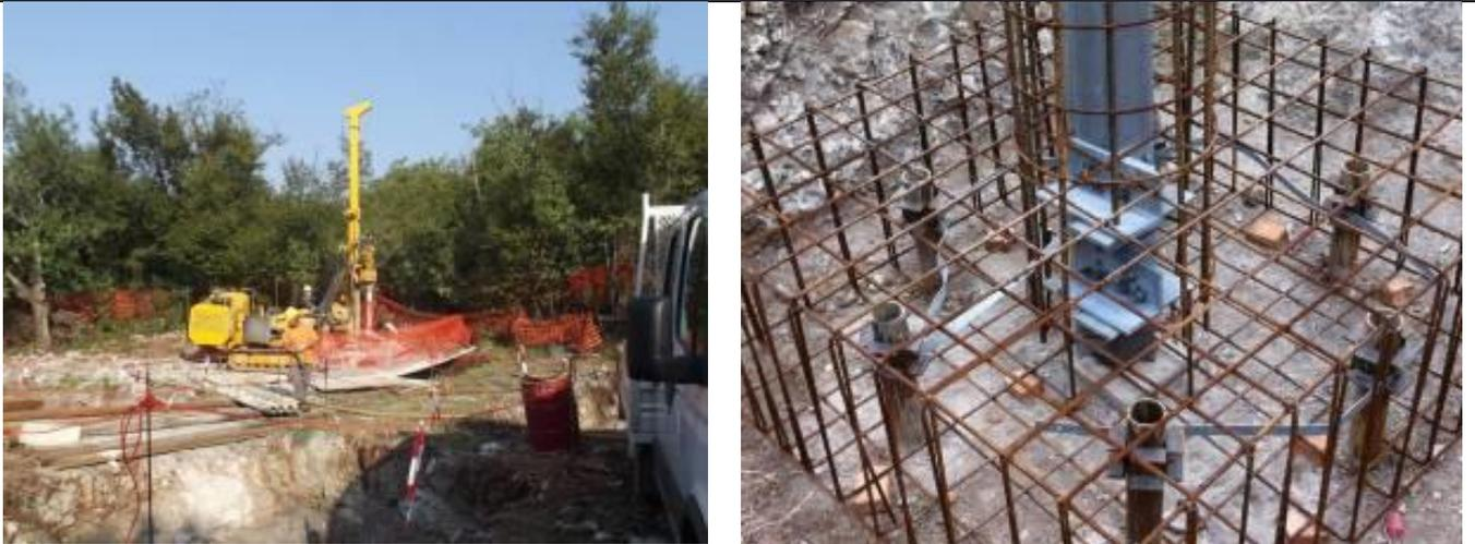
***Figura 24 - Esempio di realizzazione di una fondazione su micropali tipo tubfix. Nell'immagine di destra si può notare il particolare del raccordo tra i tubolari metallici dei micropali con l'armatura del plinto di fondazione; al centro del plinto si nota il moncone del sostegno (elemento di raccordo tra il sostegno e la fondazione) il quale viene annegato nella fondazione stessa***
