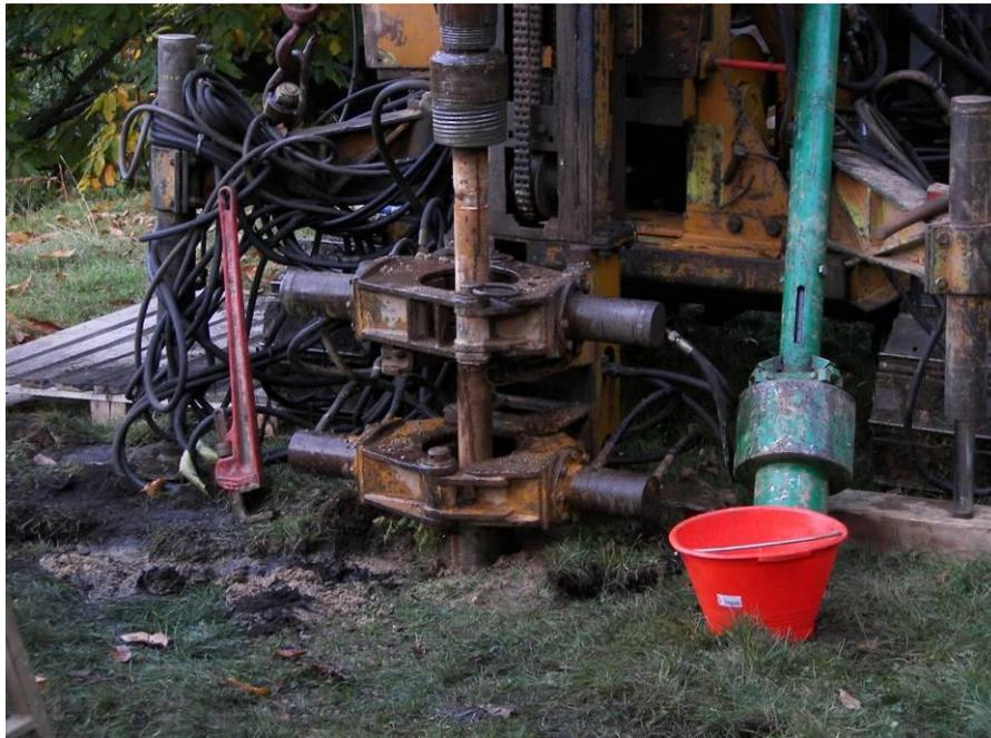
***Figura 25 - Macchina operatrice per la realizzazione di micropali tubfix; sistema di scavo a rotopercolazione***
