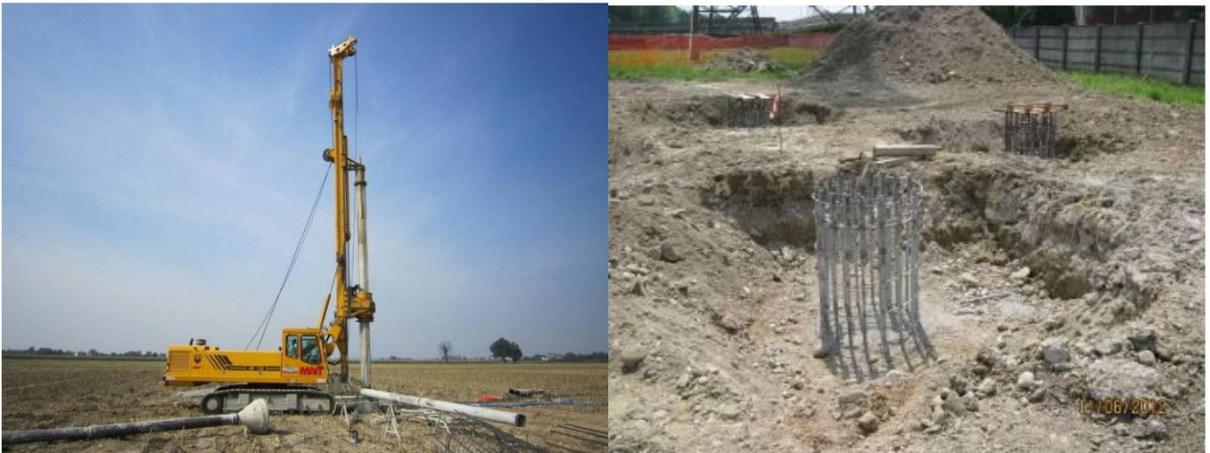
**Figura 21 - Macchina operatrice per la realizzazione di pali trivellati**
