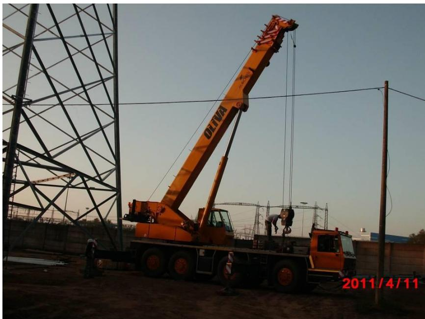
**Figura 29 - Fasi di montaggio sostegno a traliccio**
