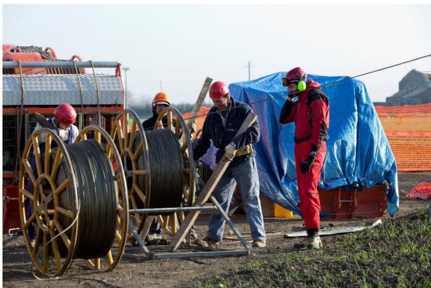
***Figura 36 - Fasi di tesatura della linea elettrica***
