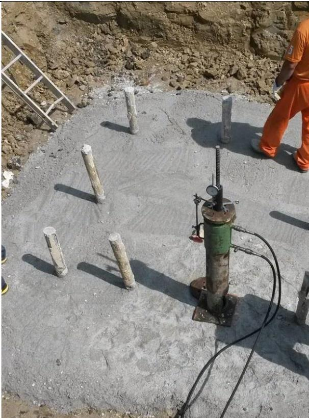
**Figura 27 - Realizzazione di micropali tipo tubfix per un sostegno a traliccio; si possono osservare i 9 micropali già realizzati ed iniettati; in questa fase, prima dell'armatura e cassatura del plinto di fondazione, si sta eseguendo una prova di tenuta del micropalo allo strappamento, al fine di verificare la corretta progettazione e realizzazione dello stesso**
