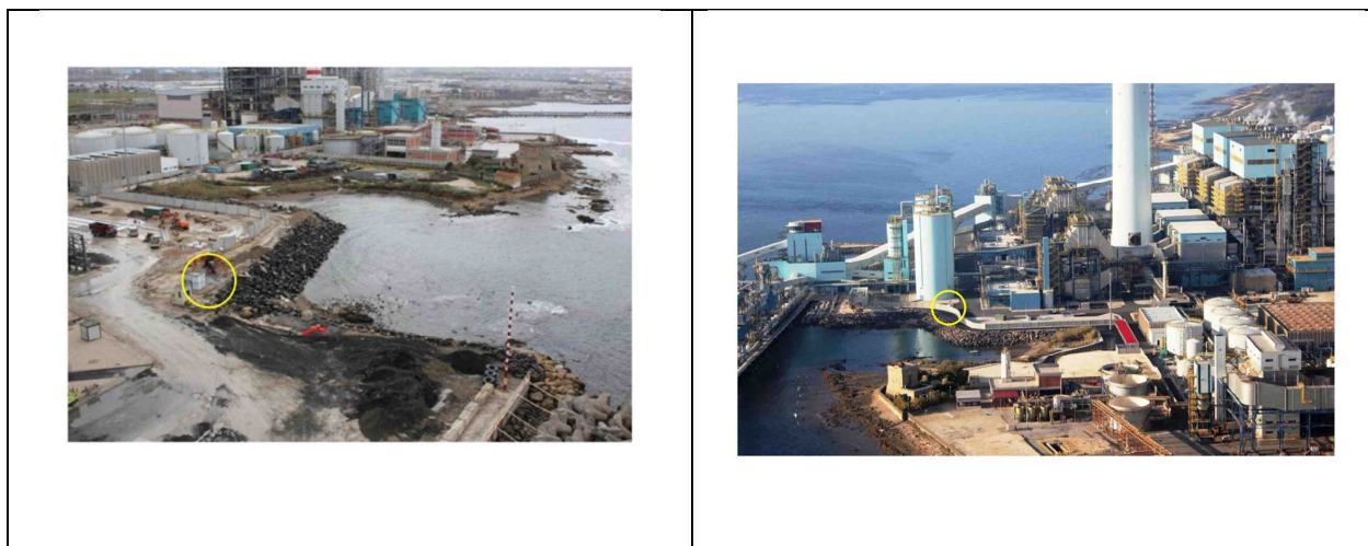
Figura 4 – Ubicazione della postazione P3 – Cabina SMI durante e dopo i lavori edili
